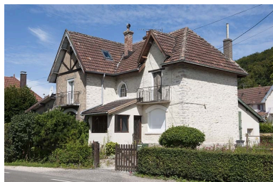
Maison de contremaîtres vue de trois quarts. Phot. Jérôme Mongreville IVR43_20112502151NUC4A
