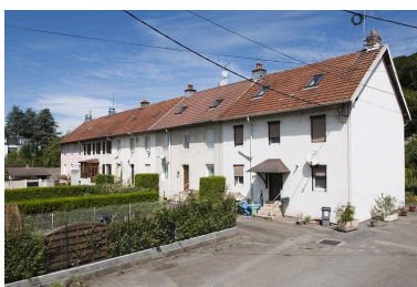
Habitation de 10 logements. Phot. Jérôme Mongreville IVR43_20112502156NUC4A
