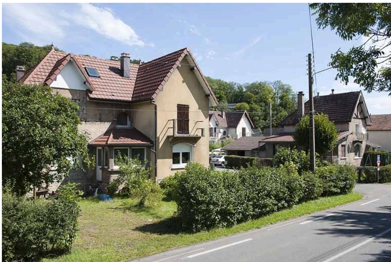
Maisons à deux logements de contremaître.
