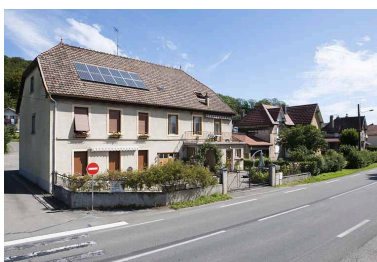
Vue d'ensemble depuis la route. Phot. Jérôme Mongreville IVR43_20112502148NUC4A
