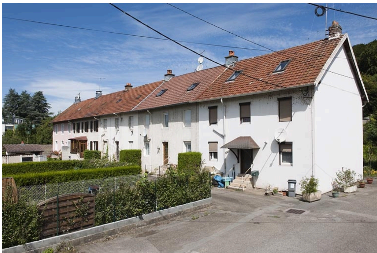
Habitation de 10 logements.
