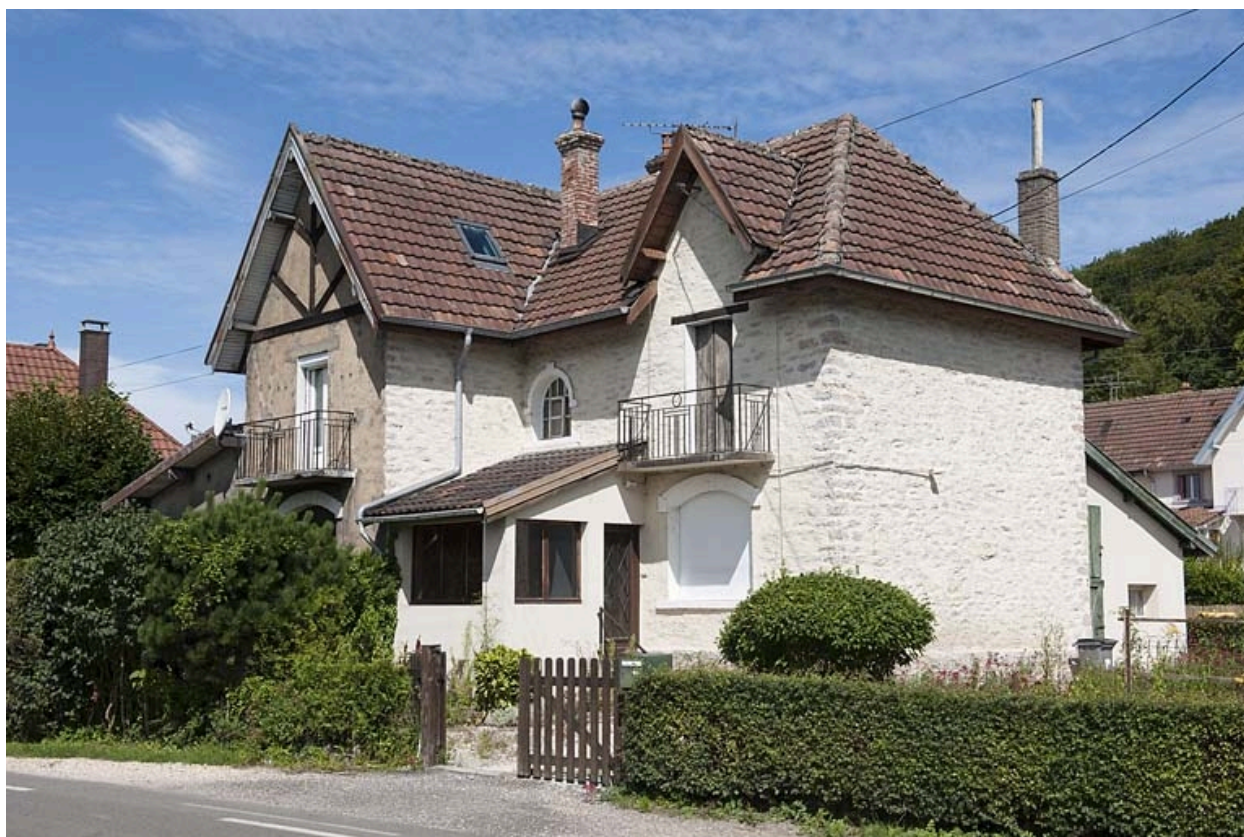
Maison de contremaîtres vue de trois quarts.
