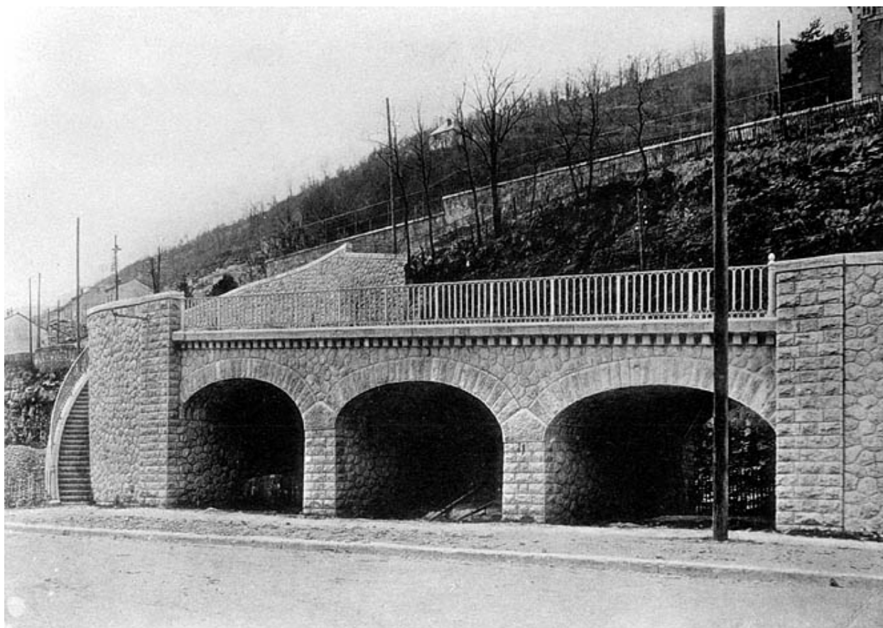
2. — ACCÈS AU PASSAGE SUPÉRIEUR VOÛTÉ du Pt 238 H + 41 m
