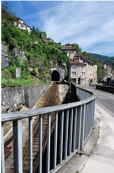
Rampe d'accès et son garde-corps, depuis le pont. A gauche, tunnel de Saint-Claude.
