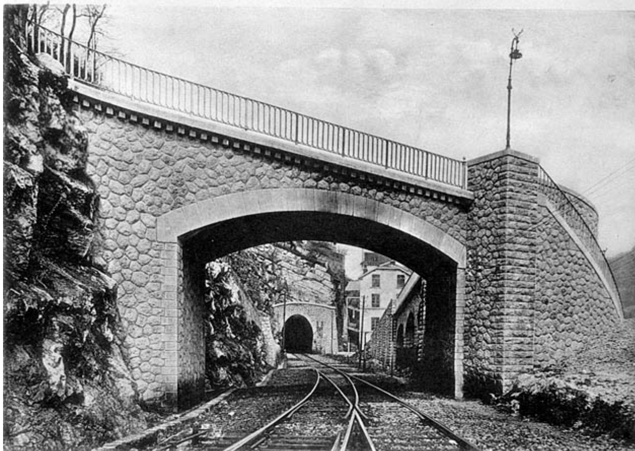
Passage supérieur voûté [...] Pt 238 H + 41 m, [1919].
