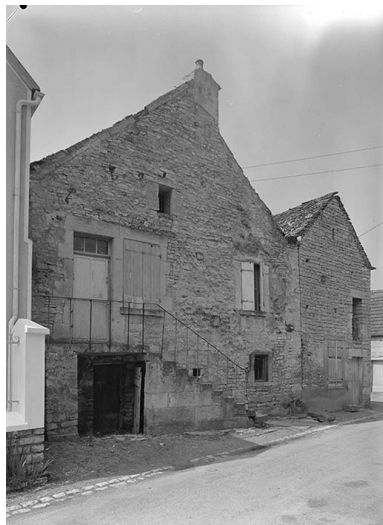
Maison sise parcelle AC 116, du cadastre de 1963. IVR26_19748900019V
