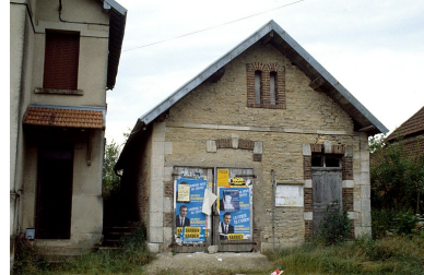
Remise vue de face. Phot. Laurent Poupard IVR43_19883900017ZA
