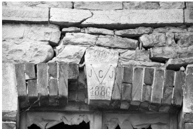
Remise, détail : clef de l'arc de la porte d'entrée. Phot. Laurent Poupard IVR43_19883900018Z
