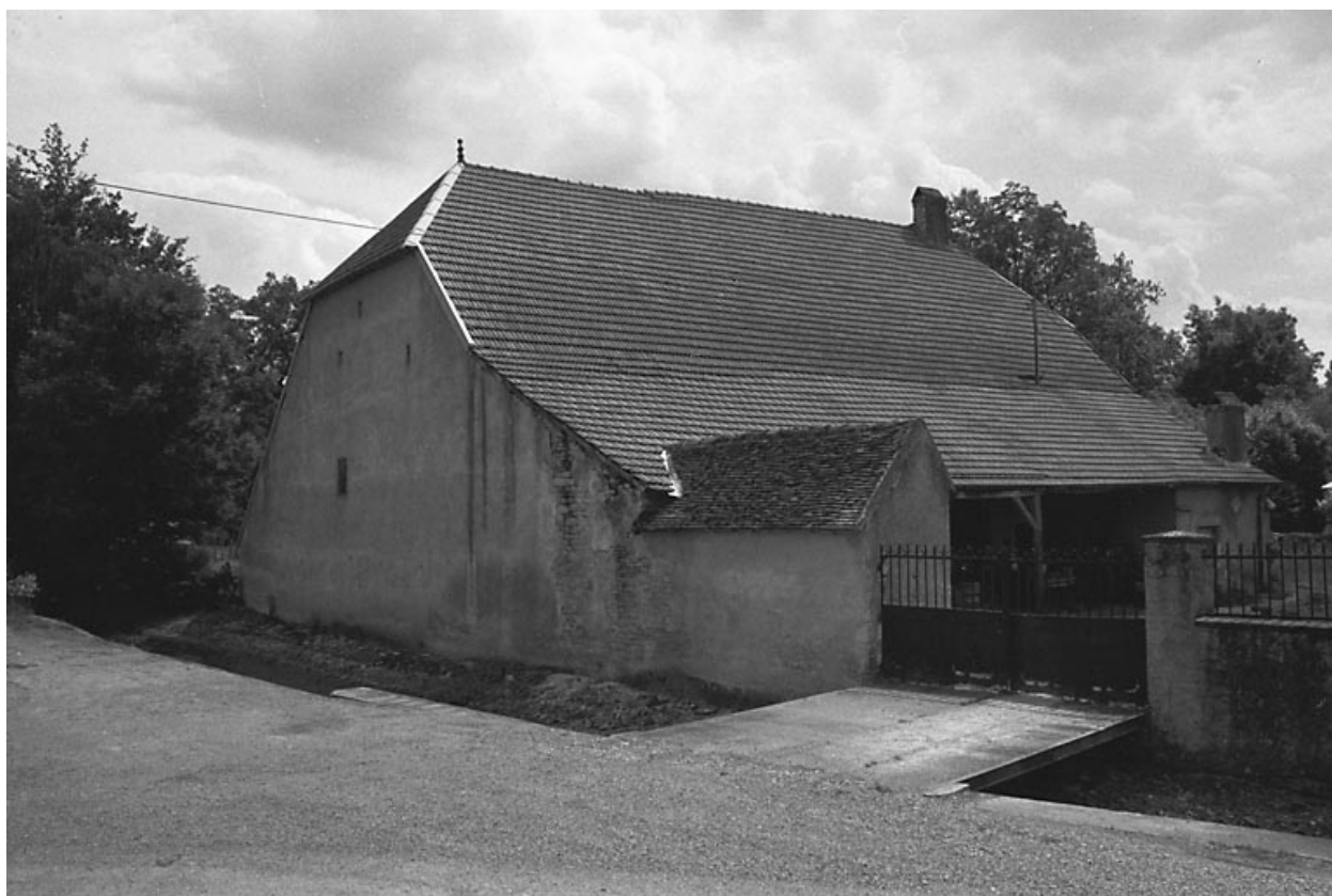
Façades antérieure et latérale gauche.
