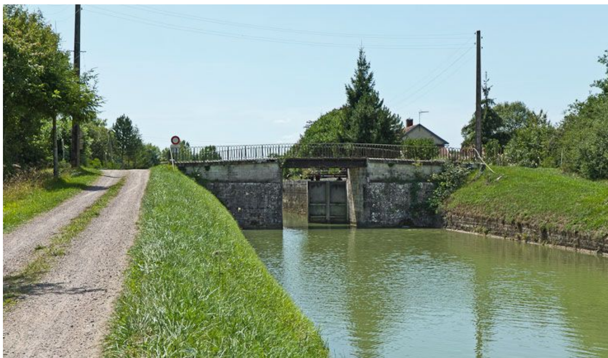
Vue du pont depuis l'aval.
