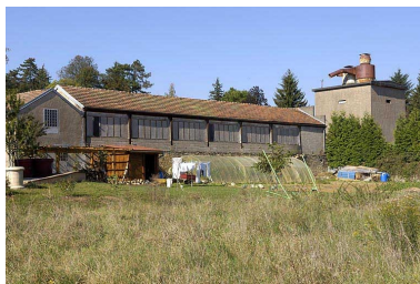
Façade sud. Phot. Jérôme Mongreville IVR43_20057000548NUCA
