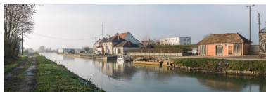
Vue d'amont, au premier plan la remise. Phot. Pierre-Marie Barbe-Richaud IVR26_20132101052NUC4AQ
