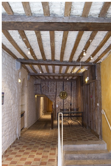
Vue d'ensemble du couloir. Phot. Yves Sancey IVR43_20112502632NUC2A
