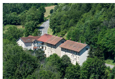
Vue d'ensemble plongeante rapprochée, depuis le sud-est. Phot. Sonia Dourlot IVR43_20192501429NUC4A
