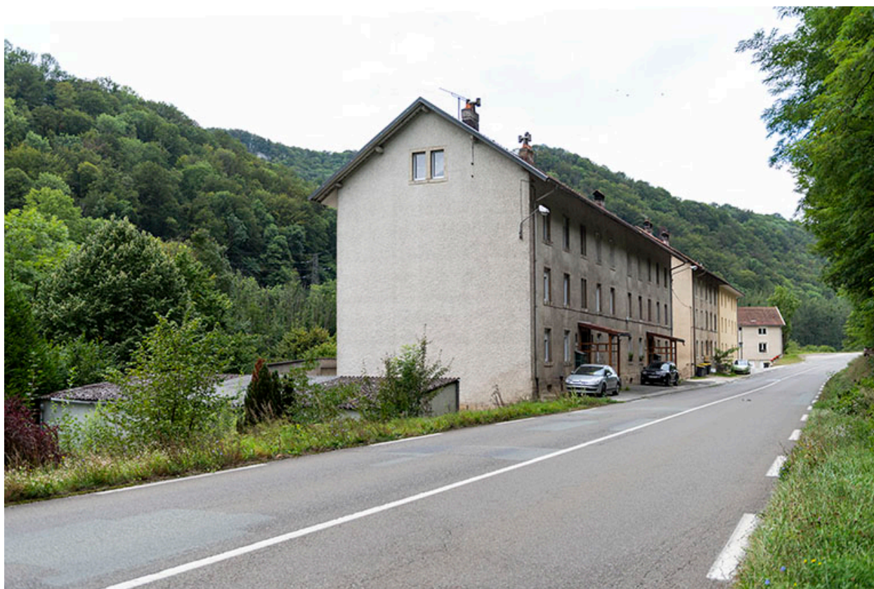
Vue d'ensemble, depuis la route à l'est.
