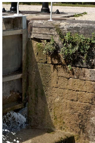
Détail de la maçonnerie du sas d'écluse. Phot. Pierre-Marie Barbe-Richaud IVR26_20112103573NUC4AQ
