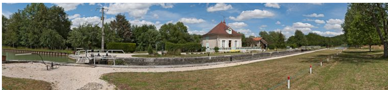
Vue d'ensemble du site d'écluse.
