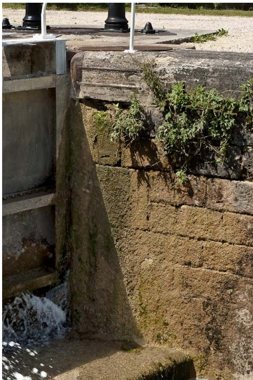
Détail de la maçonnerie du sas d'écluse.
