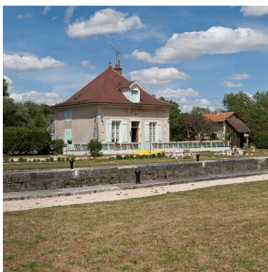
Vue de la maison éclusière. Phot. Pierre-Marie Barbe-Richaud IVR26_20112103570NUC2AQ
