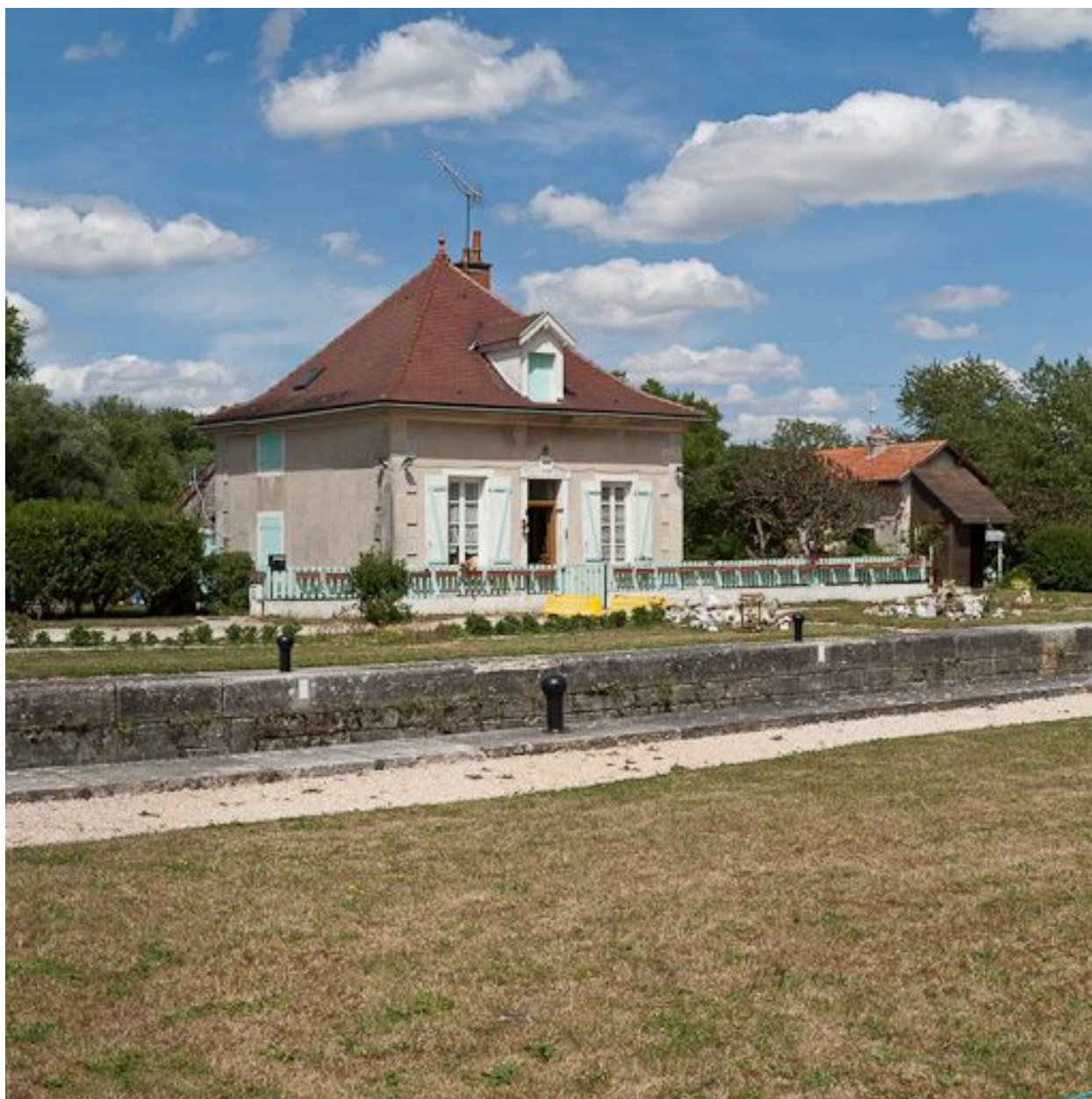
Vue de la maison éclusière.
