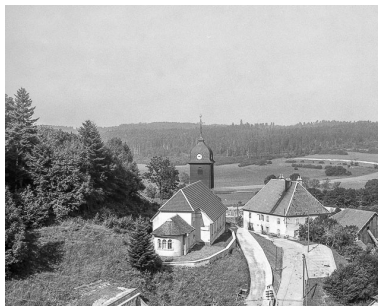
Vue de situation. Phot. Yves Sancey IVR43_19752500548X
