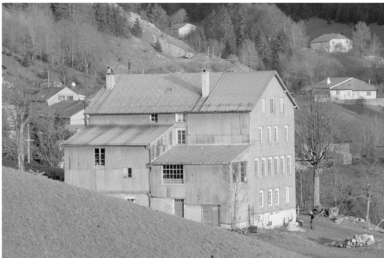
Façades postérieure et latérale droite.
