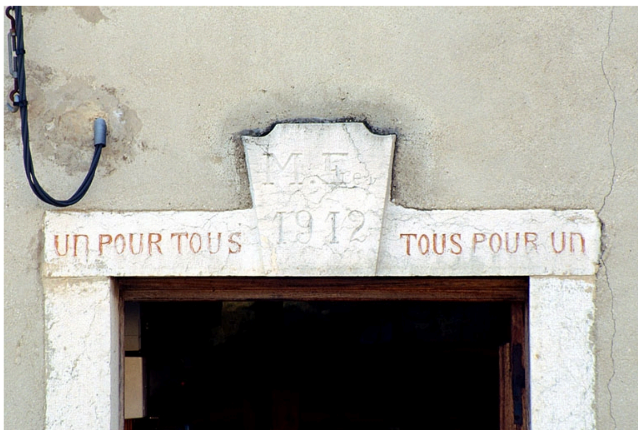
Linteau de la porte d'entrée.
