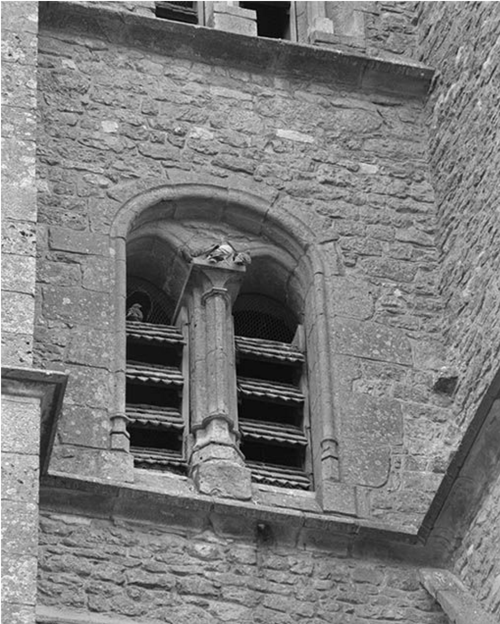
Clocher, face gauche : baies inférieures.
