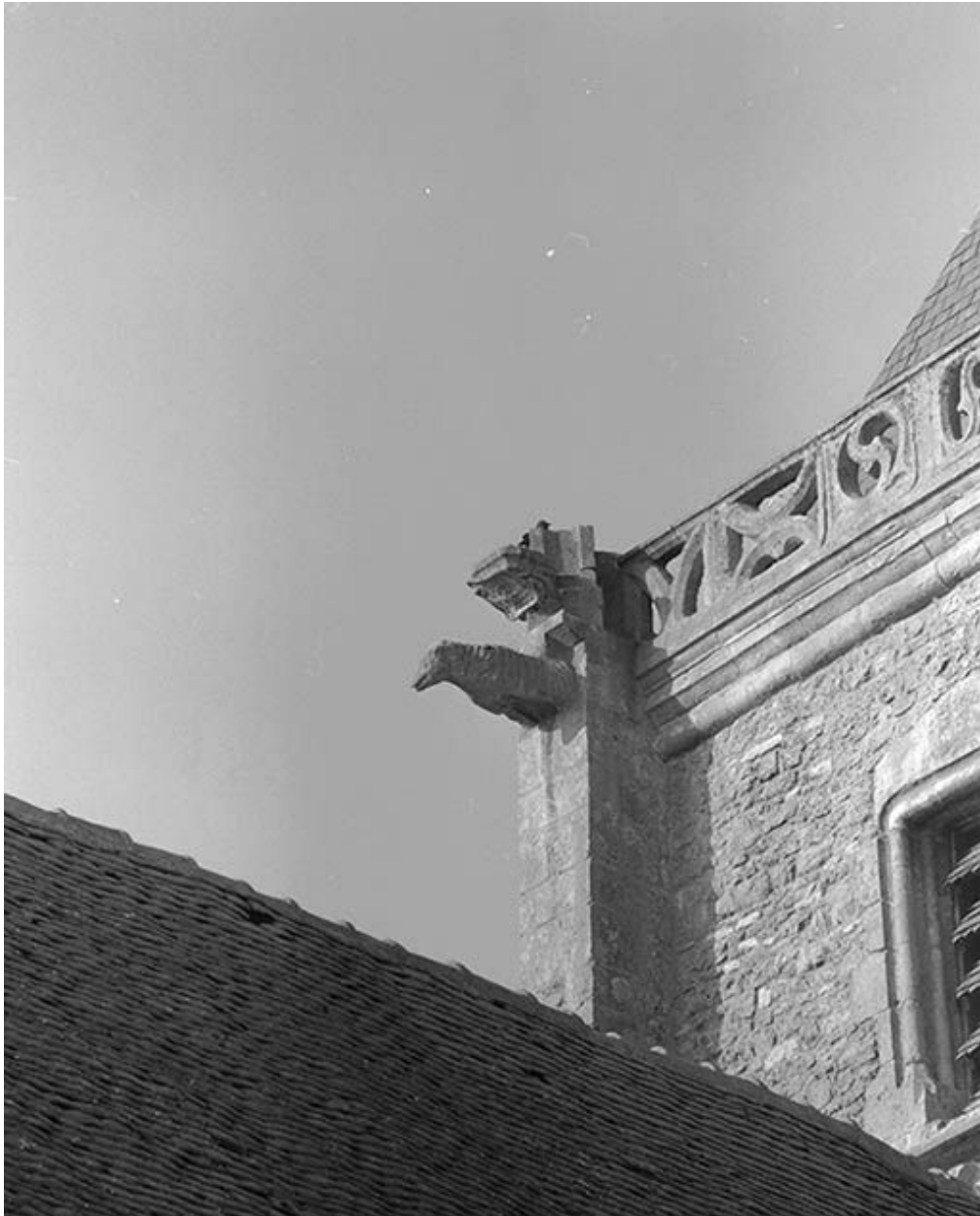
Clocher, angle postérieur droit.
