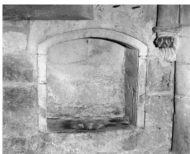
Chapelle droite : lavabo. Phot. Jean-Luc Duthu IVR26_19955800360X
