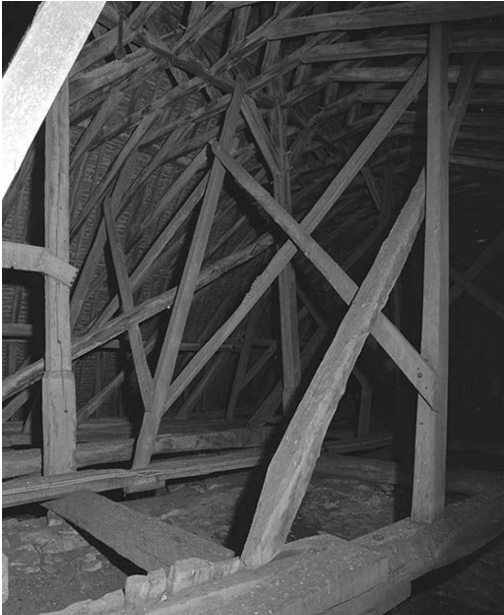
Comble : charpente de la nef.
