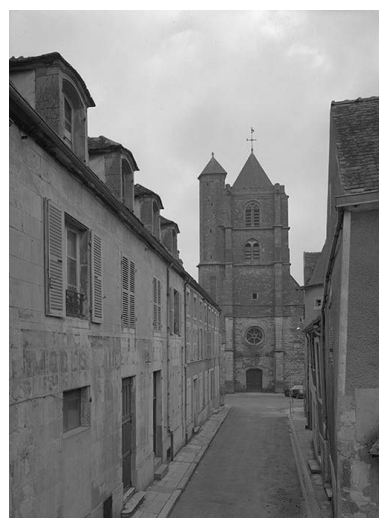
Façade antérieure. Phot. Jean-Luc Duthu IVR26_19955800394X
