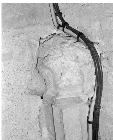
Travée sous clocher : culot antérieur gauche. Phot. Jean-Luc Duthu IVR26_19955800381X
