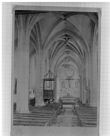
Vaisseau central en 1896. Photo ancienne. Phot. IVR26_19955800162X
