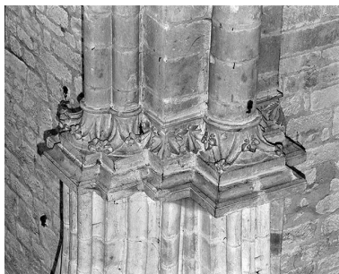
Croisée du transept : pilier postérieur gauche, détail des chapiteaux.
