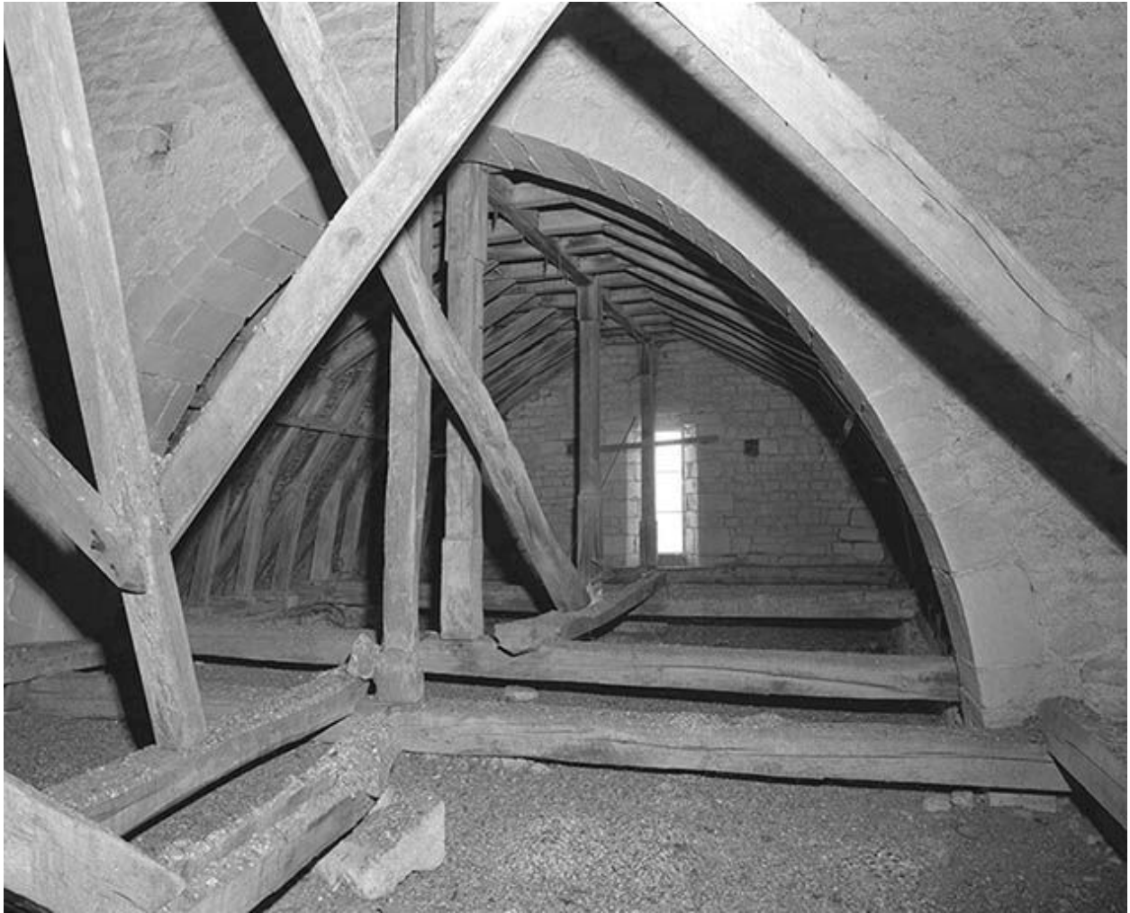
Comble : charpentes de la nef et du choeur.
