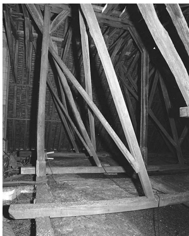
Comble de la nef : partie antérieure de la charpente. Phot. Jean-Luc Duthu IVR26_19955800327X
