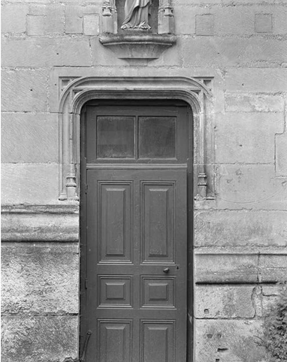
Elévation gauche, 3e travée : porte latérale.
