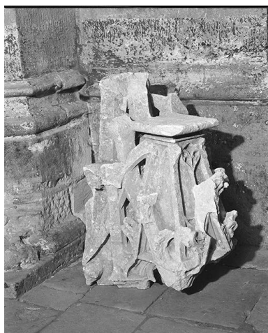
Pinacle du clocher n °2, déposé dans la nef. Phot. Jean-Luc Duthu IVR26_19955800376X
