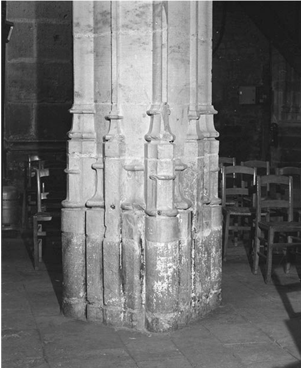
Collatéral droit, 2e travée : base du pilier antérieur gauche.
