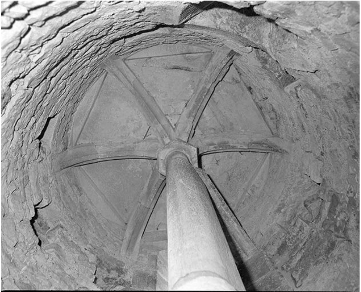
Tourelle de l'escalier du clocher : voûte.
