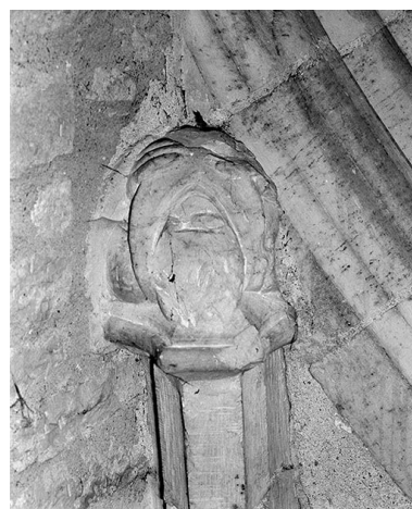
Travée sous clocher : culot antérieur droit. Phot. Jean-Luc Duthu IVR26_19955800382X
