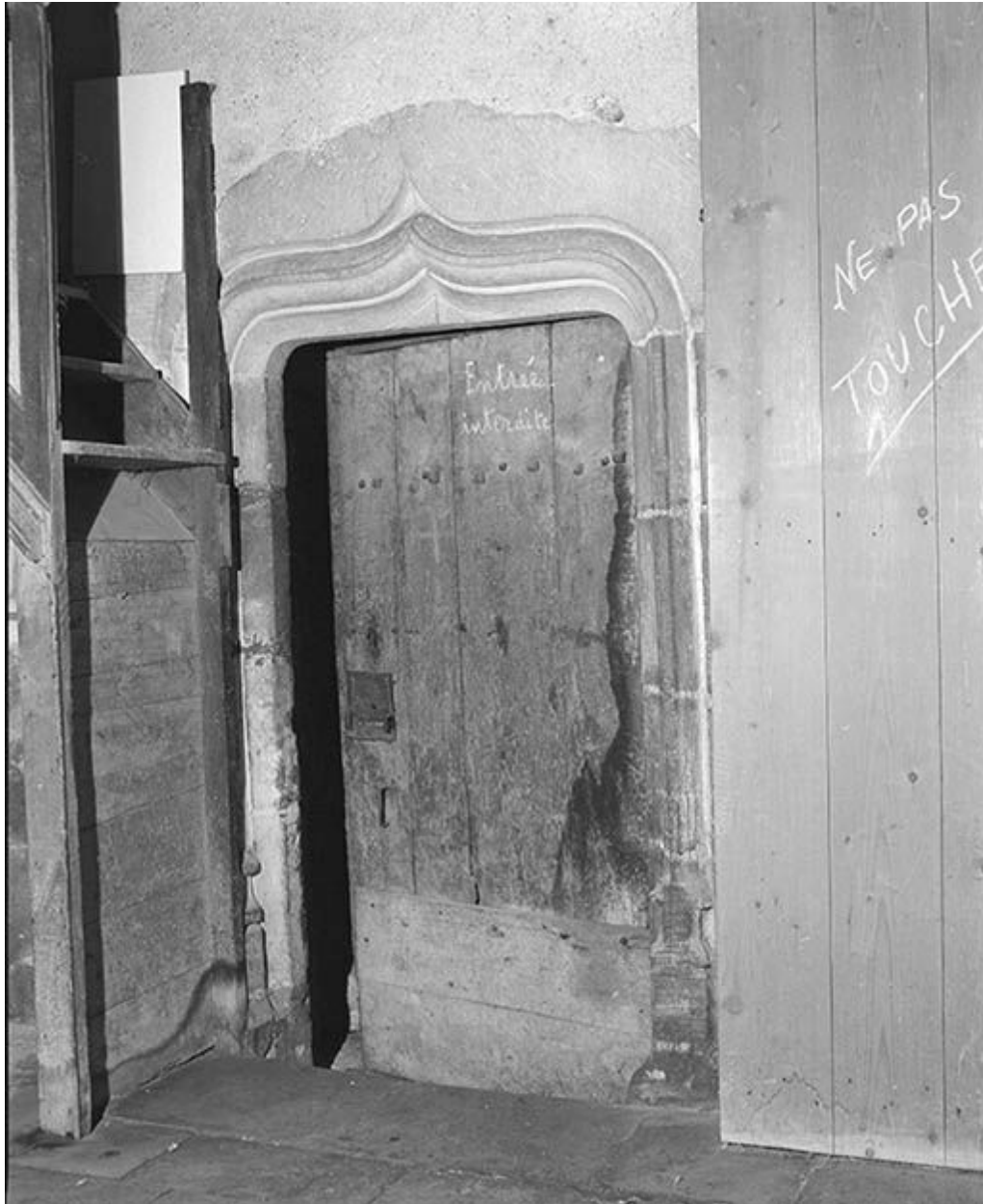
Travée à gauche du clocher, porte de la tourelle de l'escalier du clocher.
