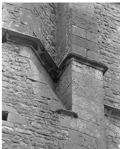
Tourelle d'escalier du clocher, détail. Phot. Jean-Luc Duthu IVR26_19955800406X
