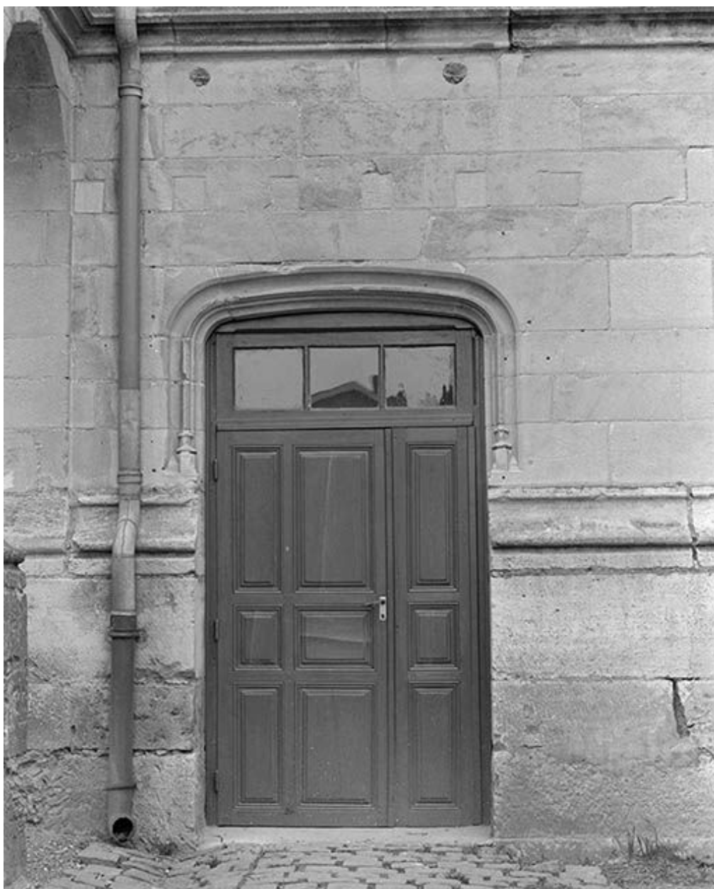
Elévation droite, 2e travée : porte latérale.
