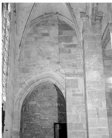
Collatéral droit, 1ère travée, arc- diaphragme antérieur ouvrant sur la chapelle des fonts baptismaux. Phot. Jean-Luc Duthu IVR26_19955800372X
