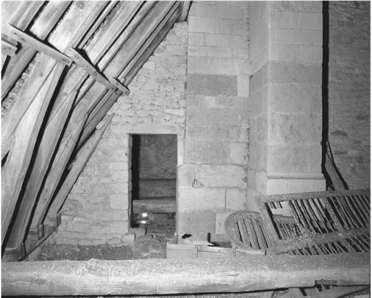
Comble de la nef : porte donnant sur le comble de la chapelle des fonts baptismaux.
