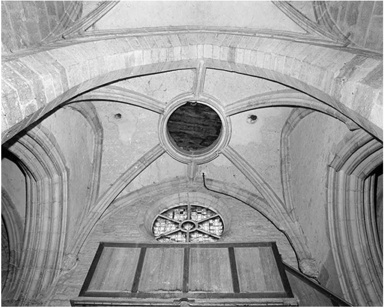
Travée sous clocher : voûte.
