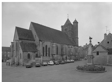
Elévation gauche et chevet. Phot. Jean-Luc Duthu IVR26_19955800399V
