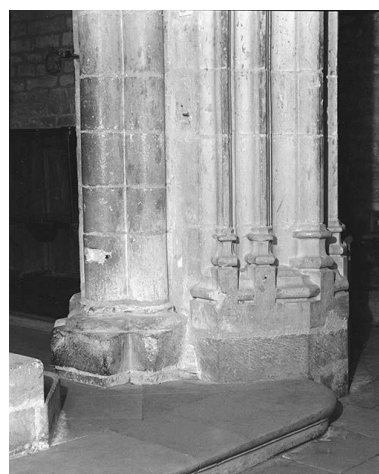
Choeur, pilier antérieur gauche. Phot. Jean-Luc Duthu IVR26_19955800345X
