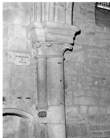
Chapelle droite : colonnette antérieure droite. Phot. Jean-Luc Duthu IVR26_19955800359X
