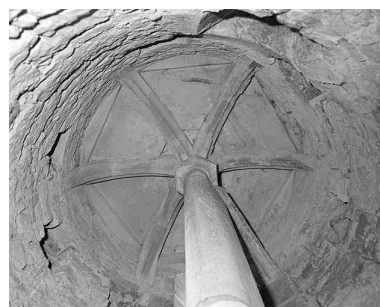
Tourelle de l'escalier du clocher : voûte. Phot. Jean-Luc Duthu IVR26_19955800336X
