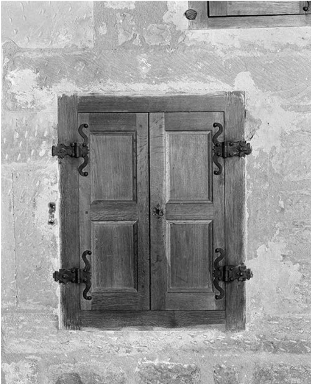
Choeur, petit placard du mur gauche, fermé.
