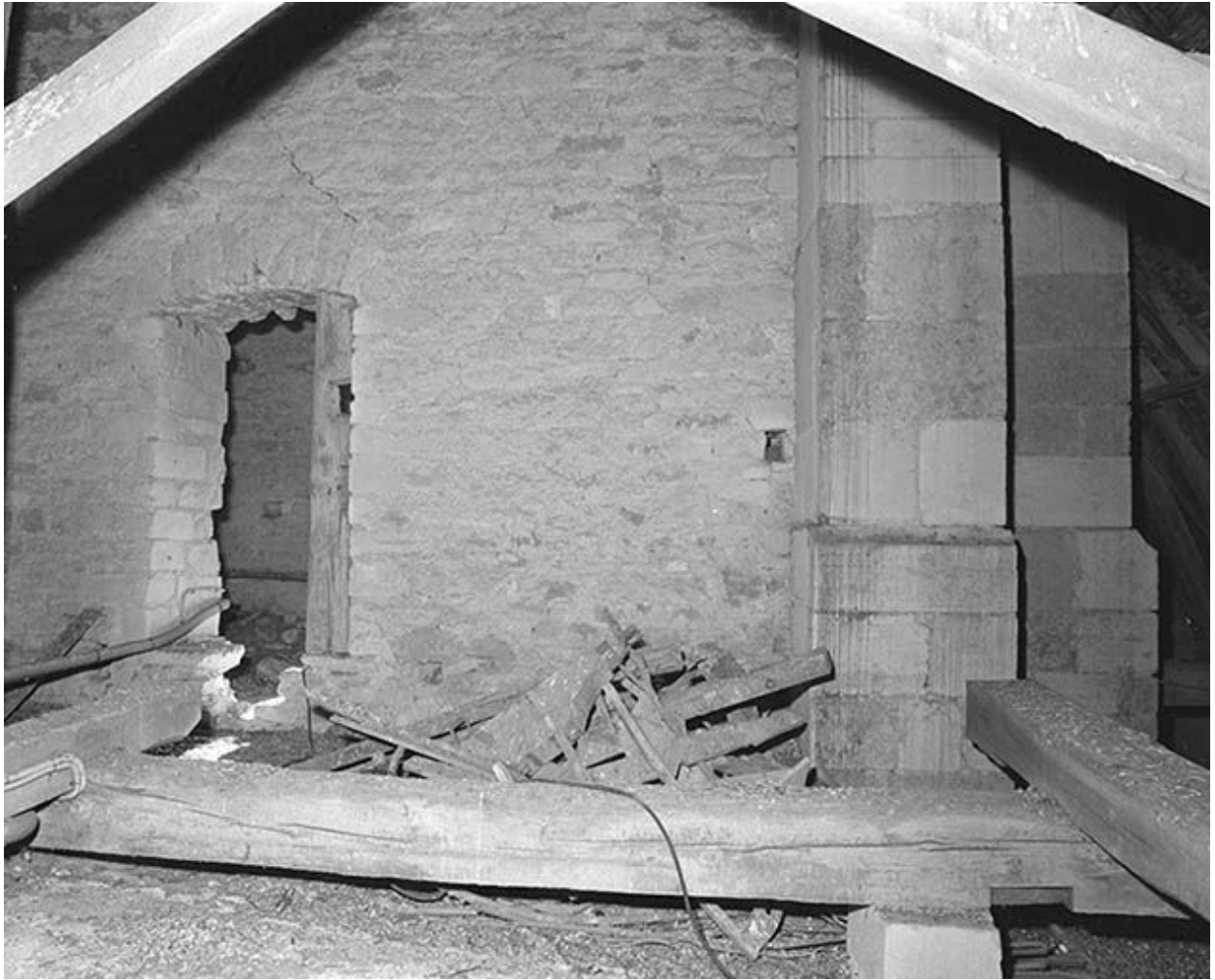
Comble de la nef : mur du clocher.
