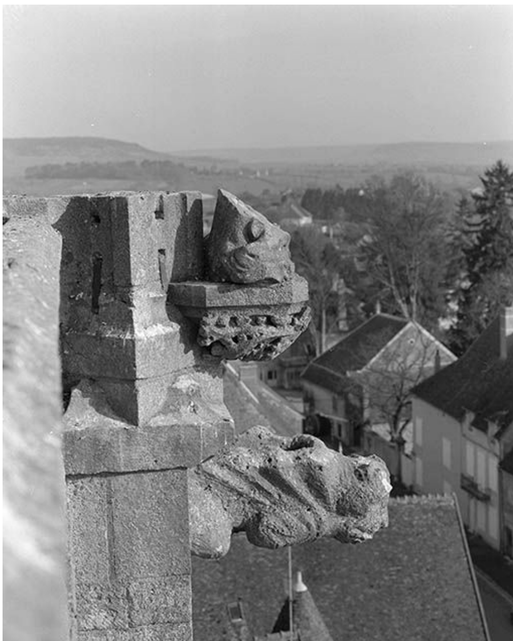
Clocher, vue rapprochée de la gargouille de l'angle postérieur gauche.
