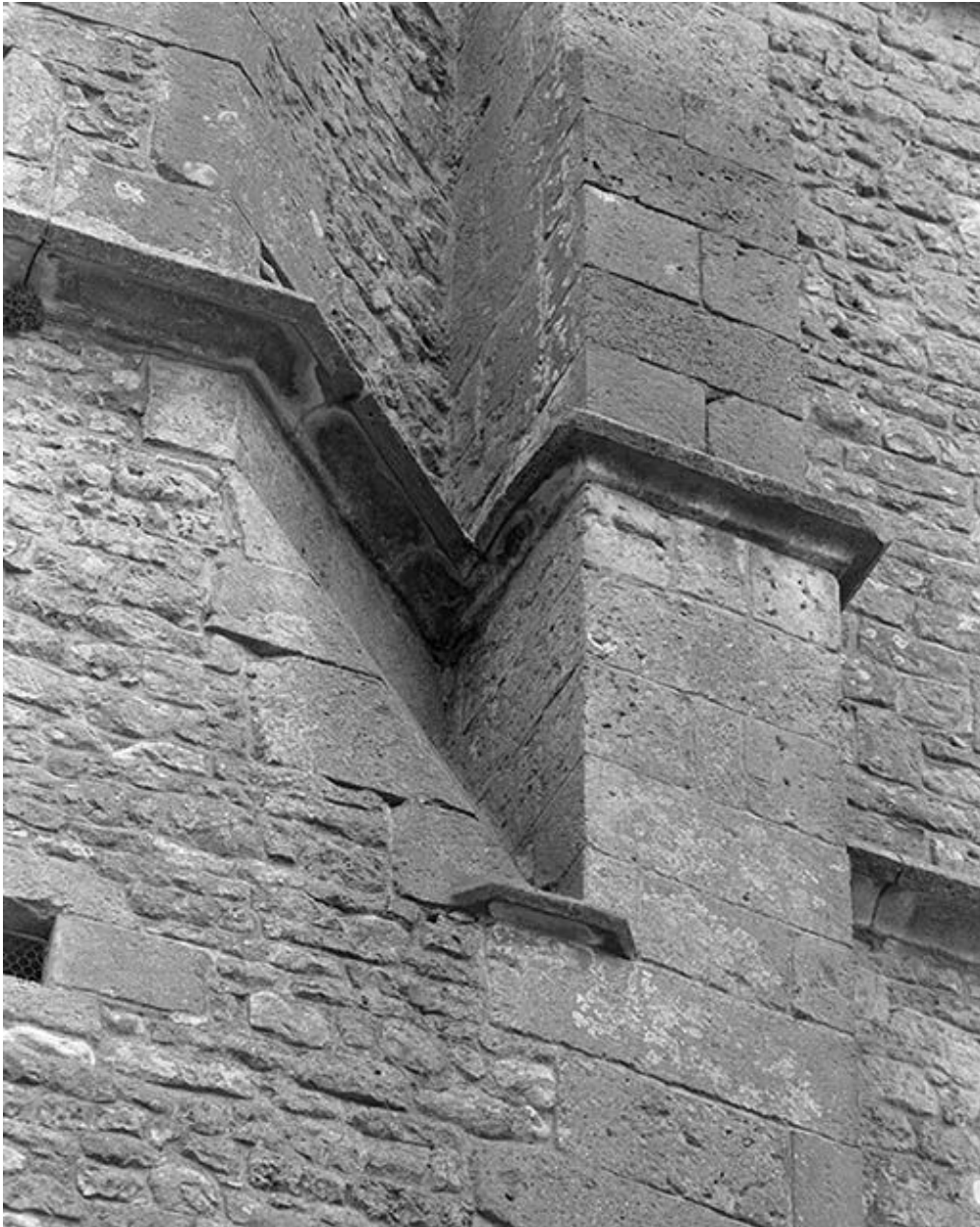
Tourelle d'escalier du clocher, détail.
