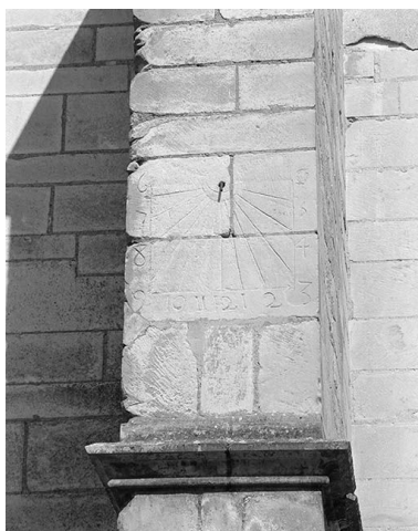
Elévation droite, 3e arc- boutant : cadran solaire. Phot. Jean-Luc Duthu IVR26_19955800351X
