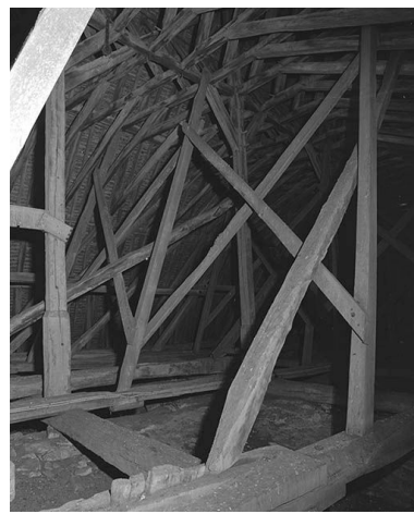
Comble : charpente de la nef. Phot. Jean-Luc Duthu IVR26_19955800330X
