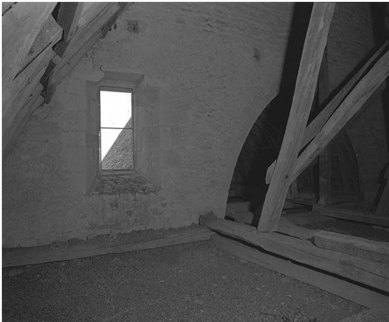
Comble : mur postérieur, à gauche de l'arcade du choeur.
