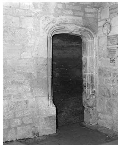
Choeur, porte de la sacristie. Phot. Jean-Luc Duthu IVR26_19955800214X
