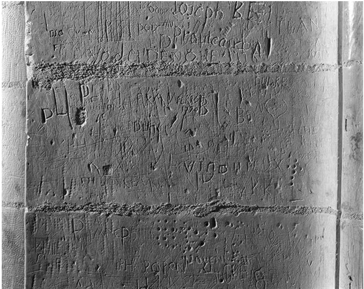
Graffiti (arcade entre le chœur et la chapelle droite).
