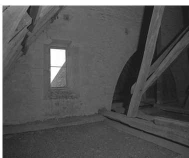
Comble : mur postérieur, à gauche de l'arcade du choeur. Phot. Jean-Luc Duthu IVR26_19955800329X
