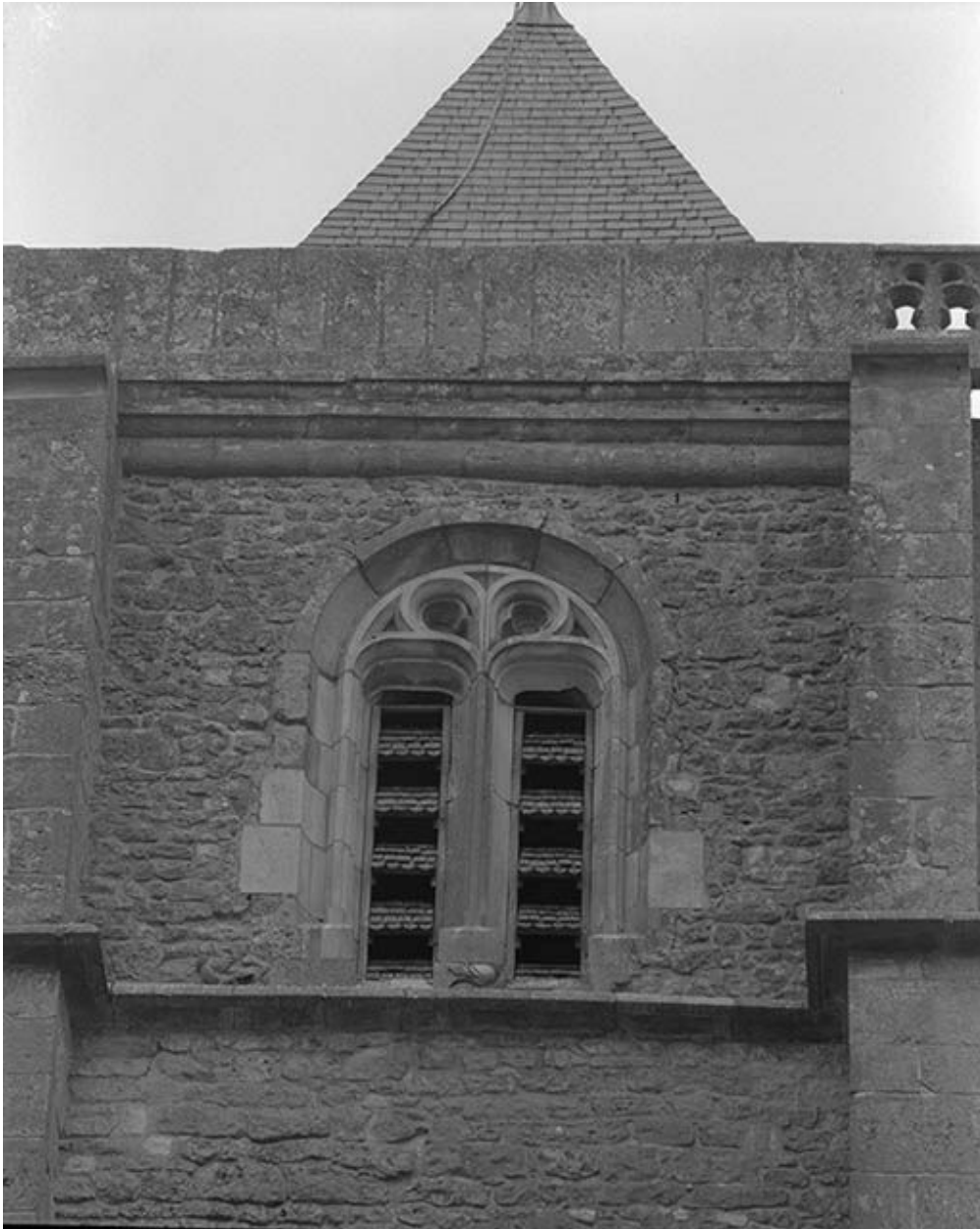
Clocher, face droite : baies supérieures
