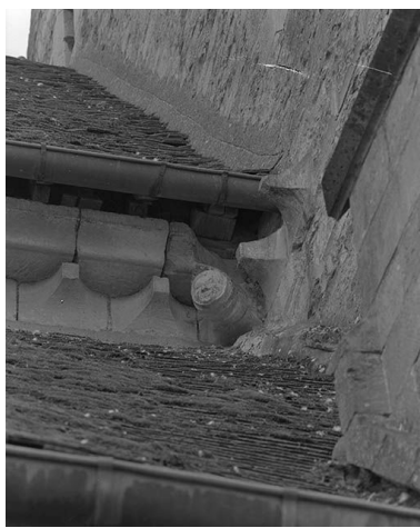
Choeur, détail de la tête ornant la corniche gauche, dans l'angle formé avec la nef. Phot. Jean-Luc Duthu IVR26_19965800166X
