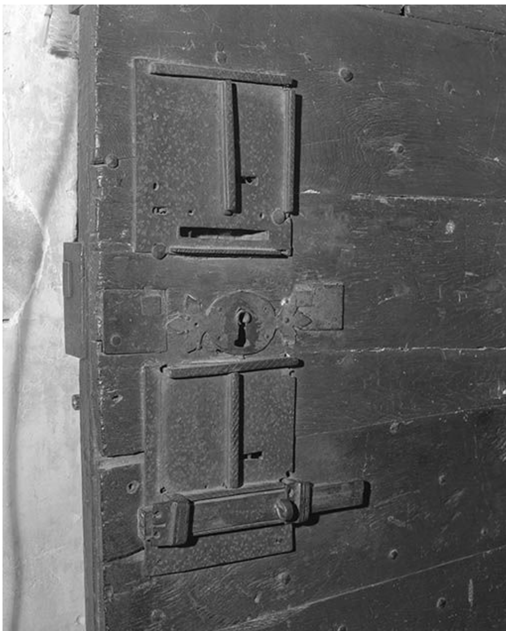
Porte de la sacristie : serrures, côté chœur.
