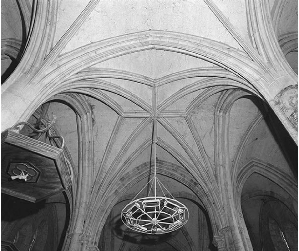
Nef, vaisseau central, 3e travée : voûte.
