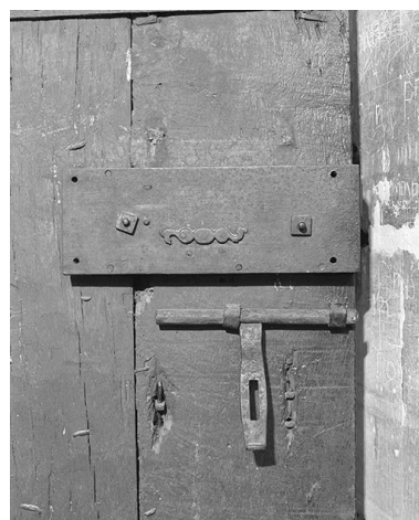
Porte de la sacristie : serrure et verrou, côté sacristie. Phot. Jean-Luc Duthu IVR26_19955800217X
