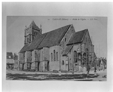
Elévation droite et chevet, en cours de restauration. Carte postale ancienne s.d. Phot. IVR26_19955800121X
