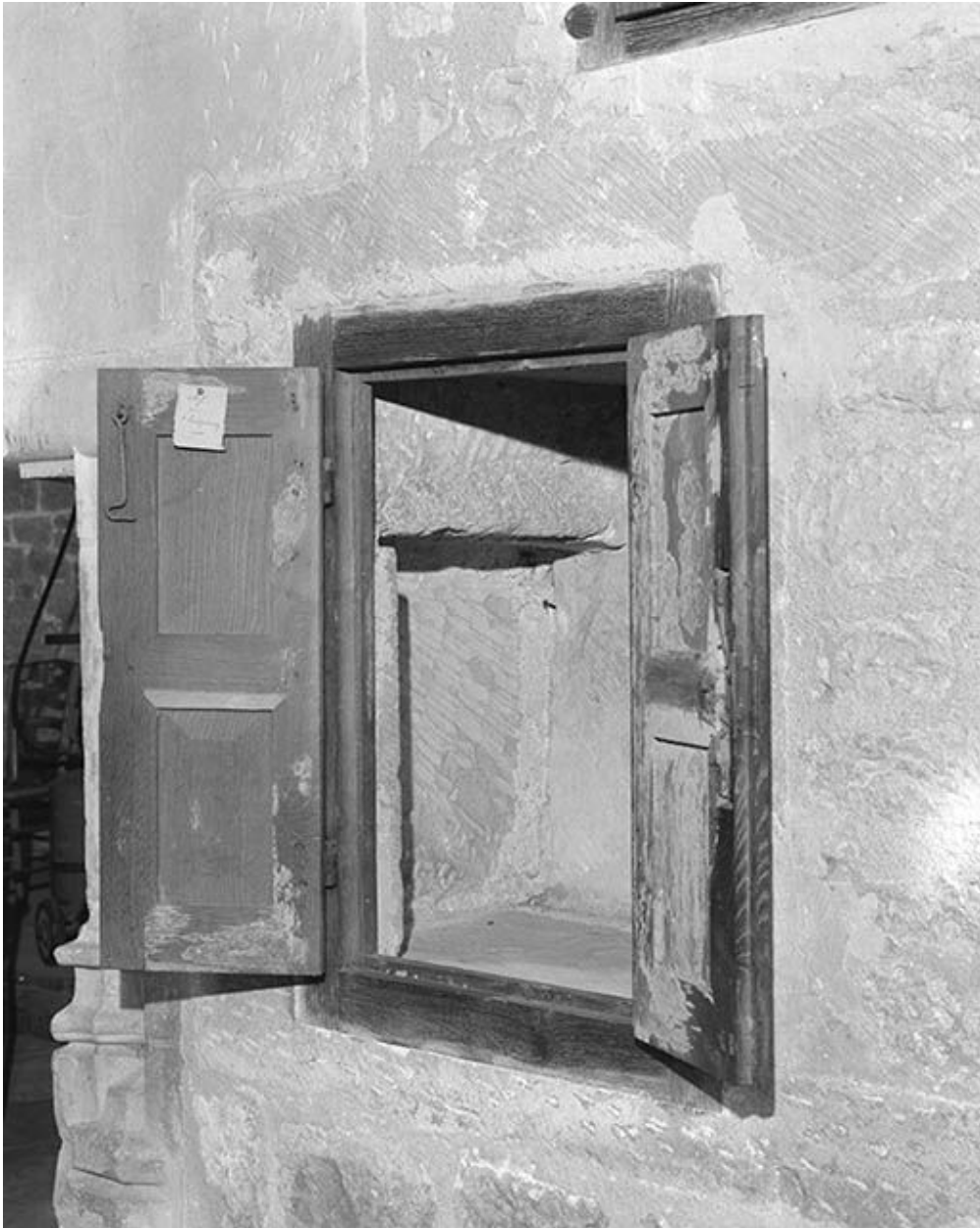
Choeur, petit placard du mur gauche, ouvert.
