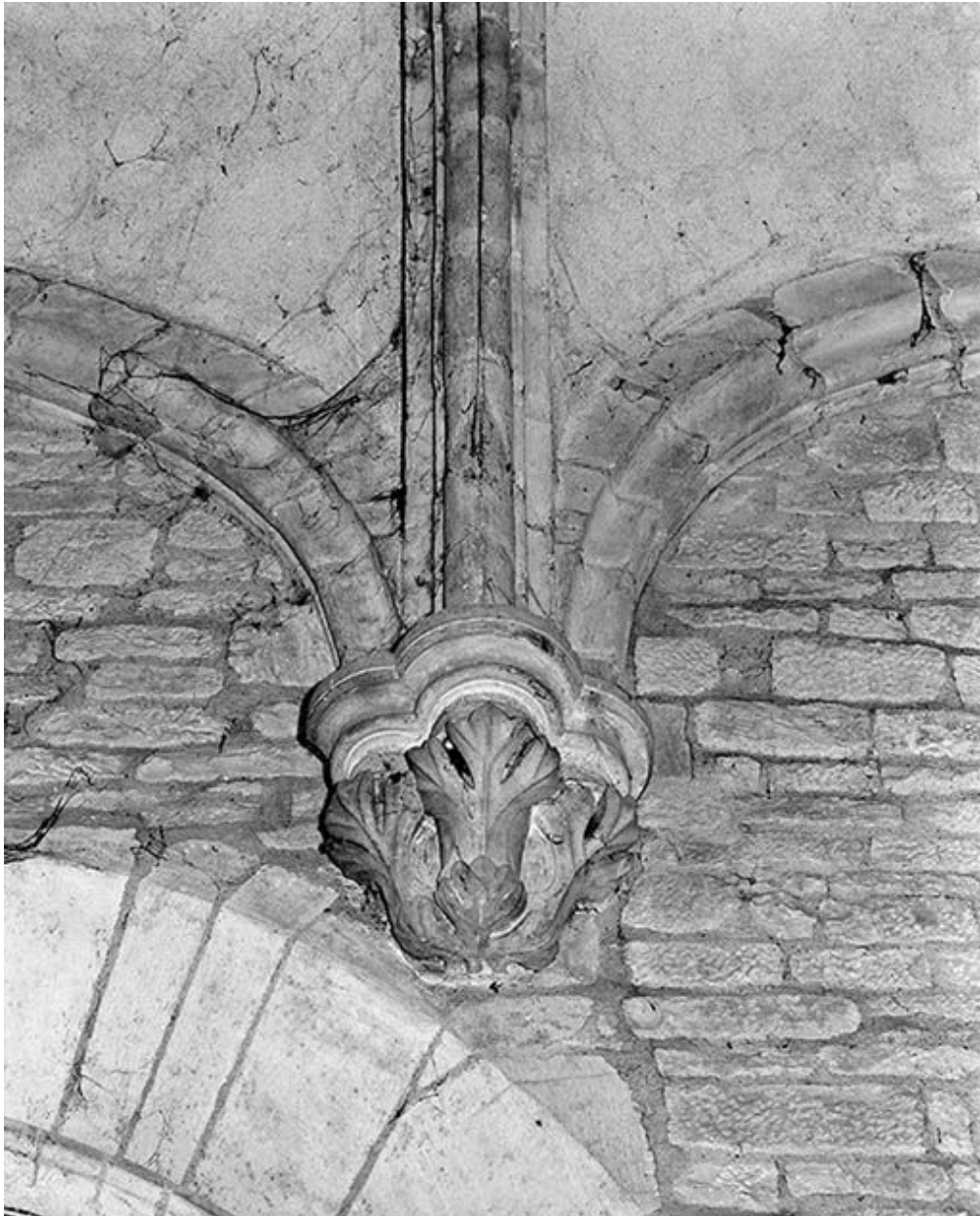
Choeur, voûte : culot droit.
