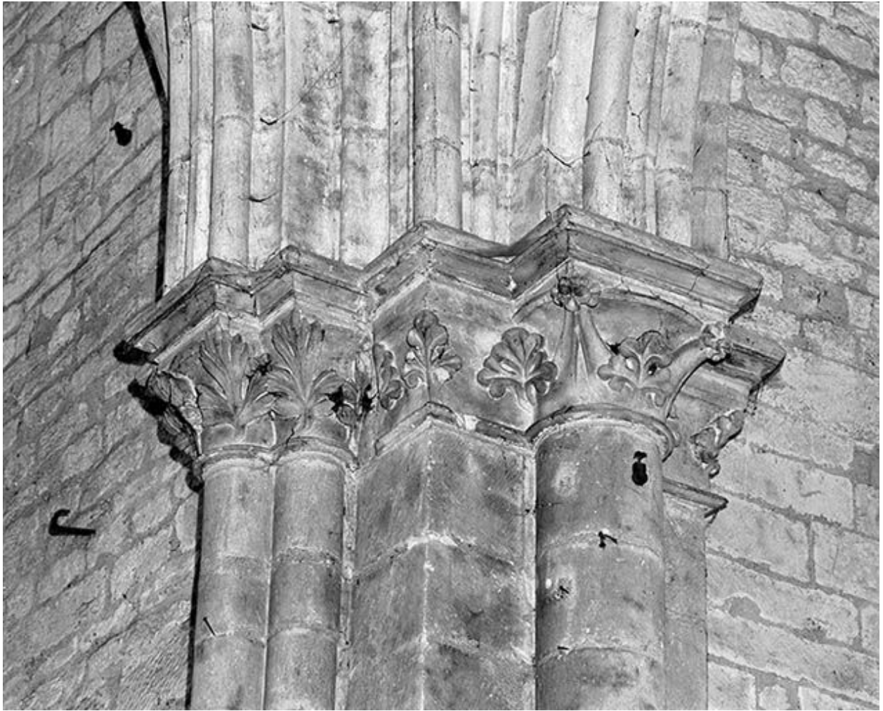
Croisée du transept : pilier postérieur droit, détail des chapiteaux.
