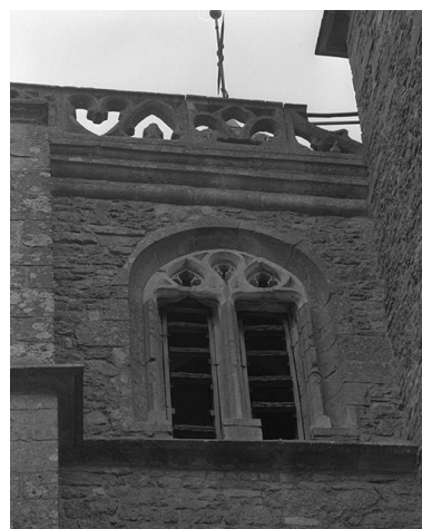
Clocher, face gauche : baies supérieures. Phot. Jean-Luc Duthu IVR26_19955800408X
