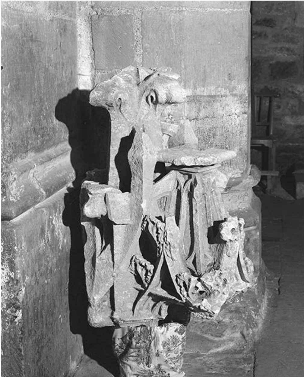
Pinacle du clocher n°1, déposé dans la nef.
