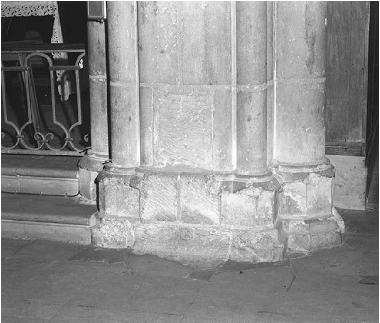
Collatéral droit, 3e travée : base du pilier postérieur gauche.
