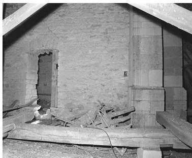
Comble de la nef : mur du clocher. Phot. Jean-Luc Duthu IVR26_19955800325X
