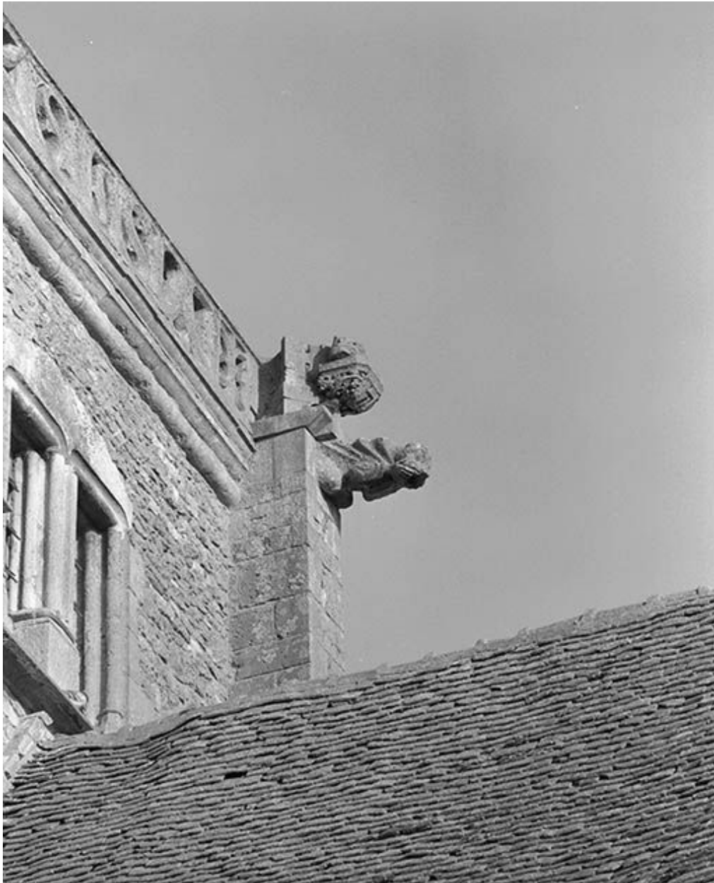
Clocher, angle postérieur gauche, côté nord.
