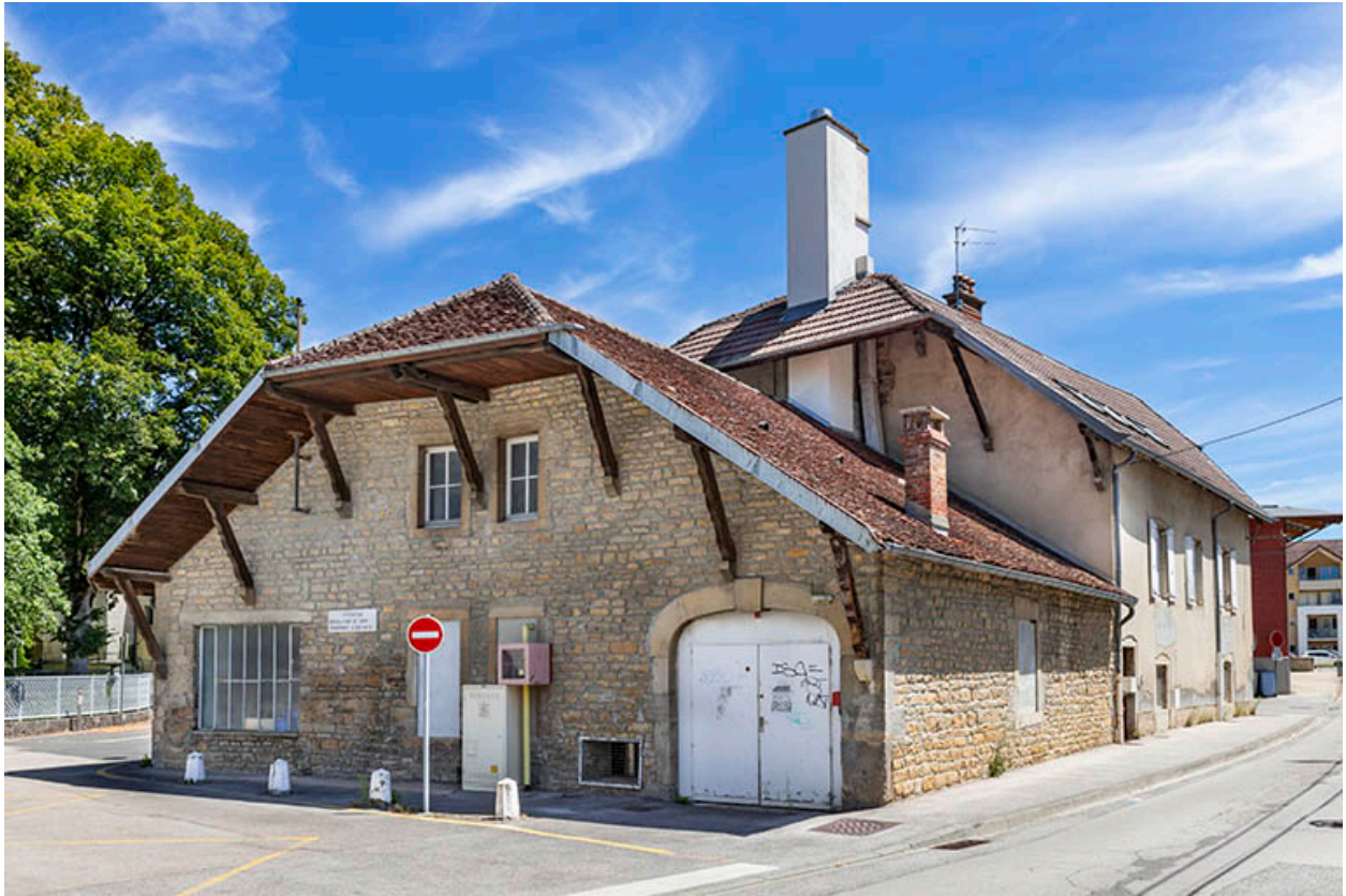
Vue depuis l'ouest.
