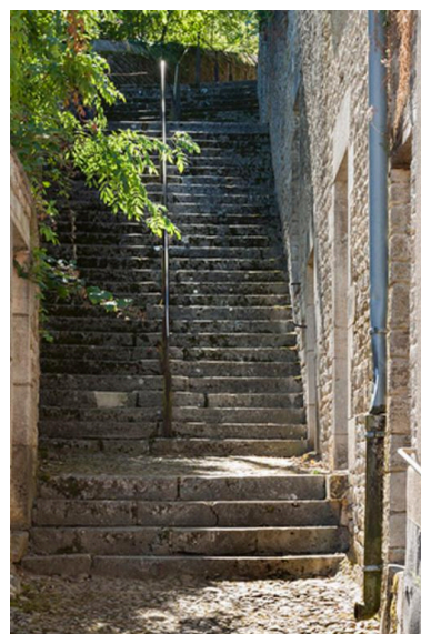
Escalier menant de la Grande Rue au château Phot. Jérôme Mongreville IVR43_20137000254NUCA
