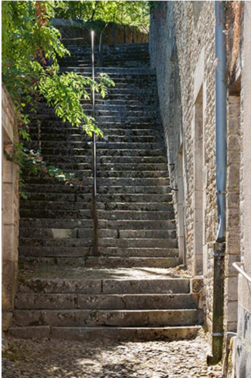
Escalier menant de la Grande Rue au château
