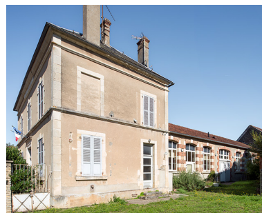
Le flanc sud. Phot. Nicolas Waltefaugle IVR26_20258900300NUC4A
