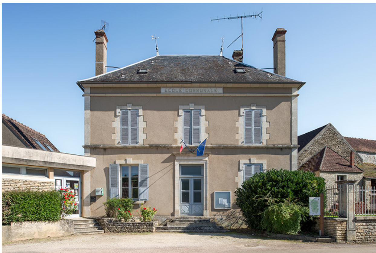
La façade principale sur la rue.
