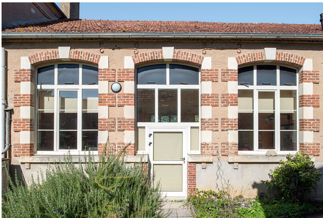
L'ancienne salle de classe, face sud.
