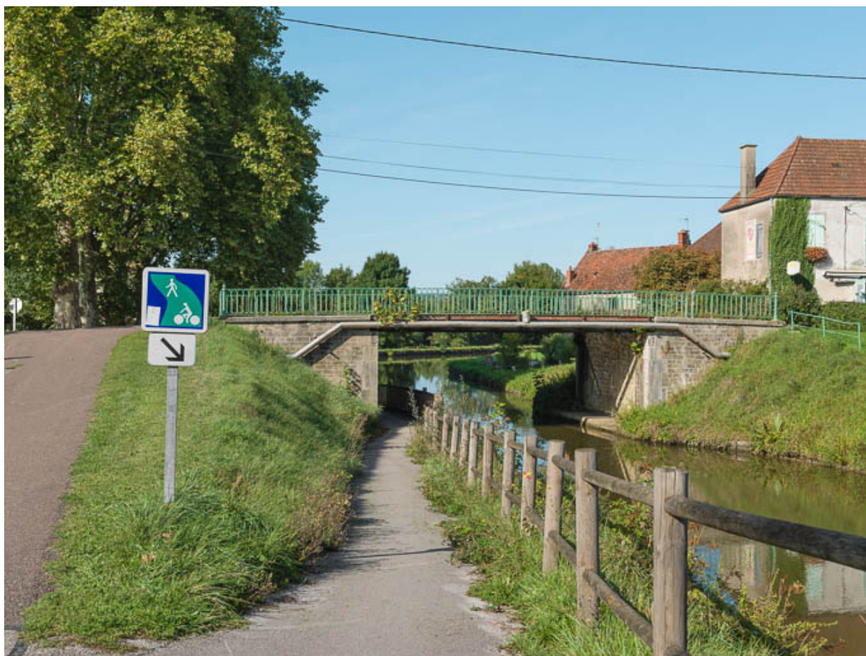
Vue d'ensemble du pont.
