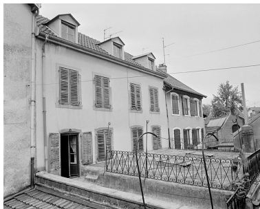
Etages de la façade sur jardin. Phot. Jérôme Mongreville IVR43_19872500555X
