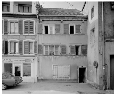
Façade sur rue. Phot. Jérôme Mongreville IVR43_19872501122V
