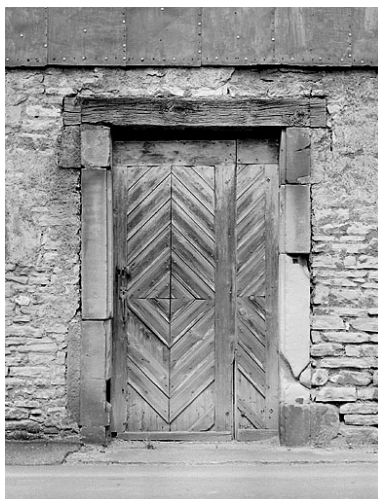
Atelier de menuiserie, porte sur la rue de la Synagogue. Phot. Jérôme Mongreville IVR43_19872500359X
