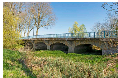
L'ensemble du pont, vu de l'ouest. Phot. Aline Thomas IVR43_20257000028NUC4A
