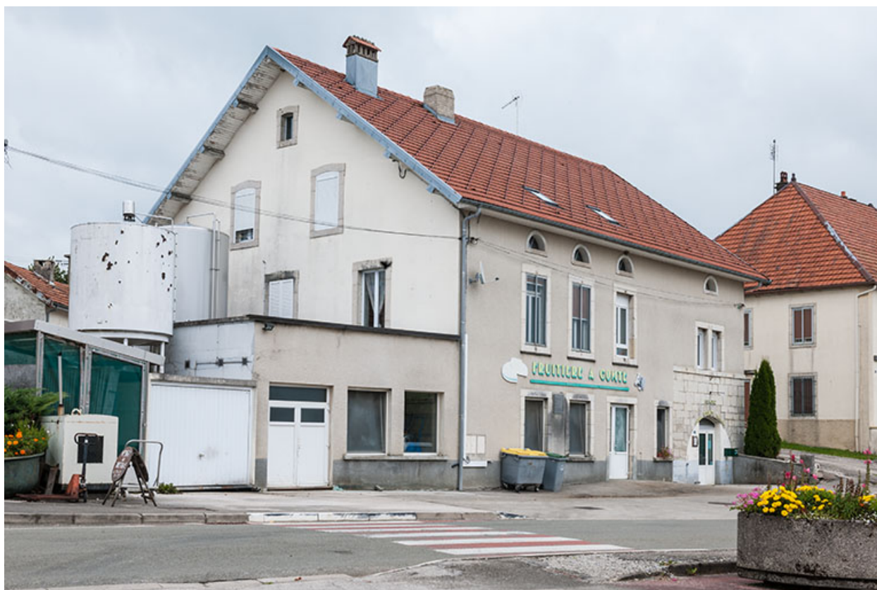
Vue depuis le sud-ouest.
