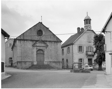
Façade antérieure. Phot. Yves Sancey IVR43_19853900205V
