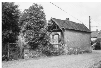
Façade postérieure de la remise. Phot. Bernard Lardière IVR43_19817000256Z
