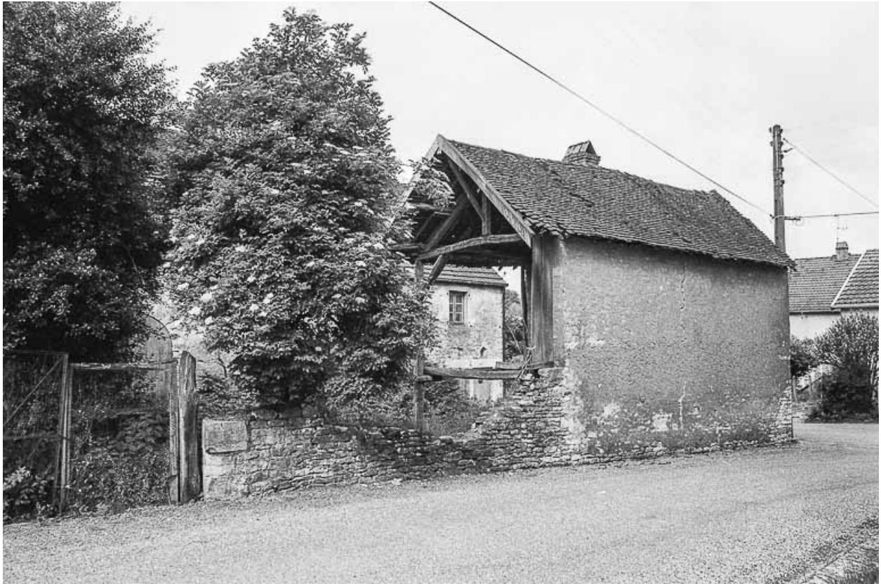
Façade postérieure de la remise.
