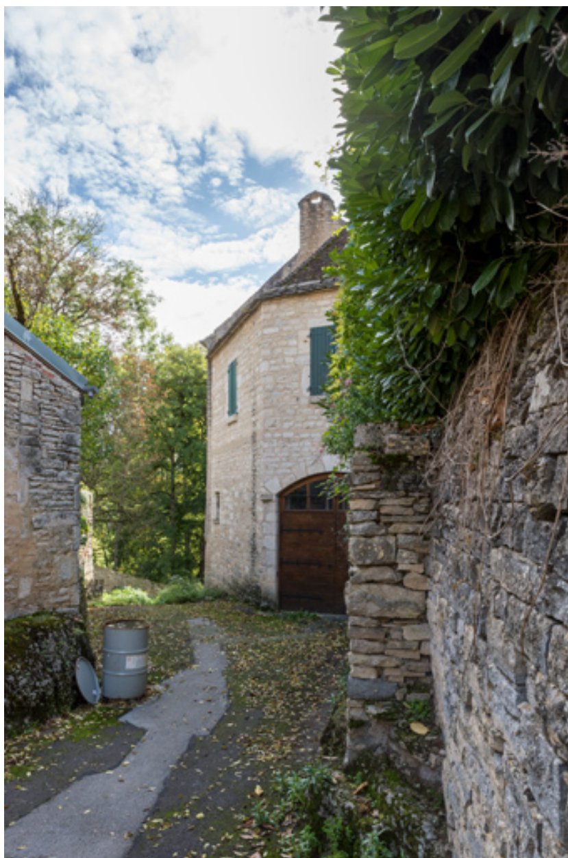
Vue éloignée de l'ancien bastion.
