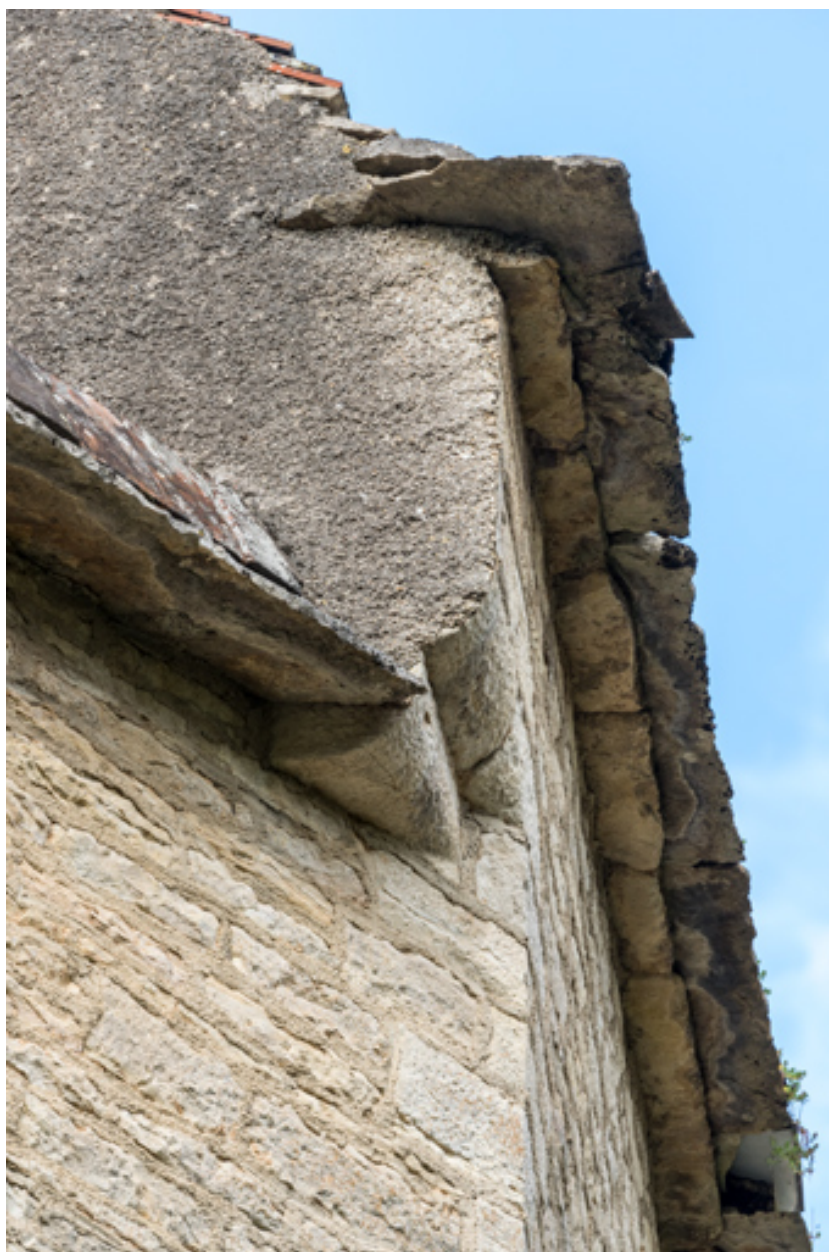
Détail des dernières assises de laves en toiture de l'ancien bastion.
