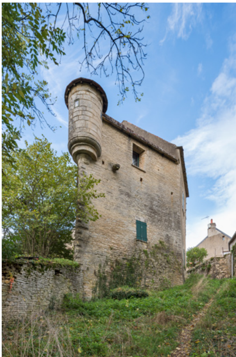
Vue de l'ancien bastion depuis le sud.
