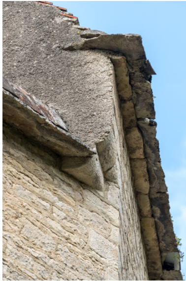
Détail des dernières assises de laves en toiture de l'ancien bastion. Phot. Pierre-Marie Barbe-Richaud IVR26_20222100985NUC4A
