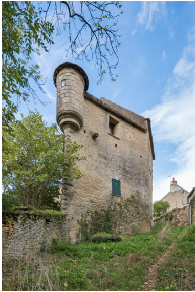
Vue de l'ancien bastion depuis le sud. Phot. Pierre-Marie Barbe-Richaud IVR26_20222100983NUC4A
