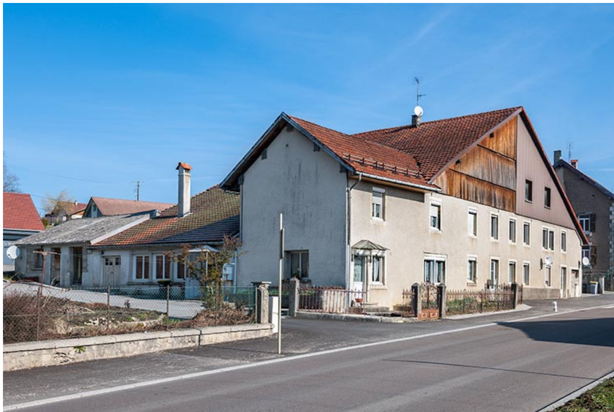
Ferme : vue d'ensemble, depuis le sud. L'atelier de galvanoplastie occupait la partie gauche des bâtiments.
