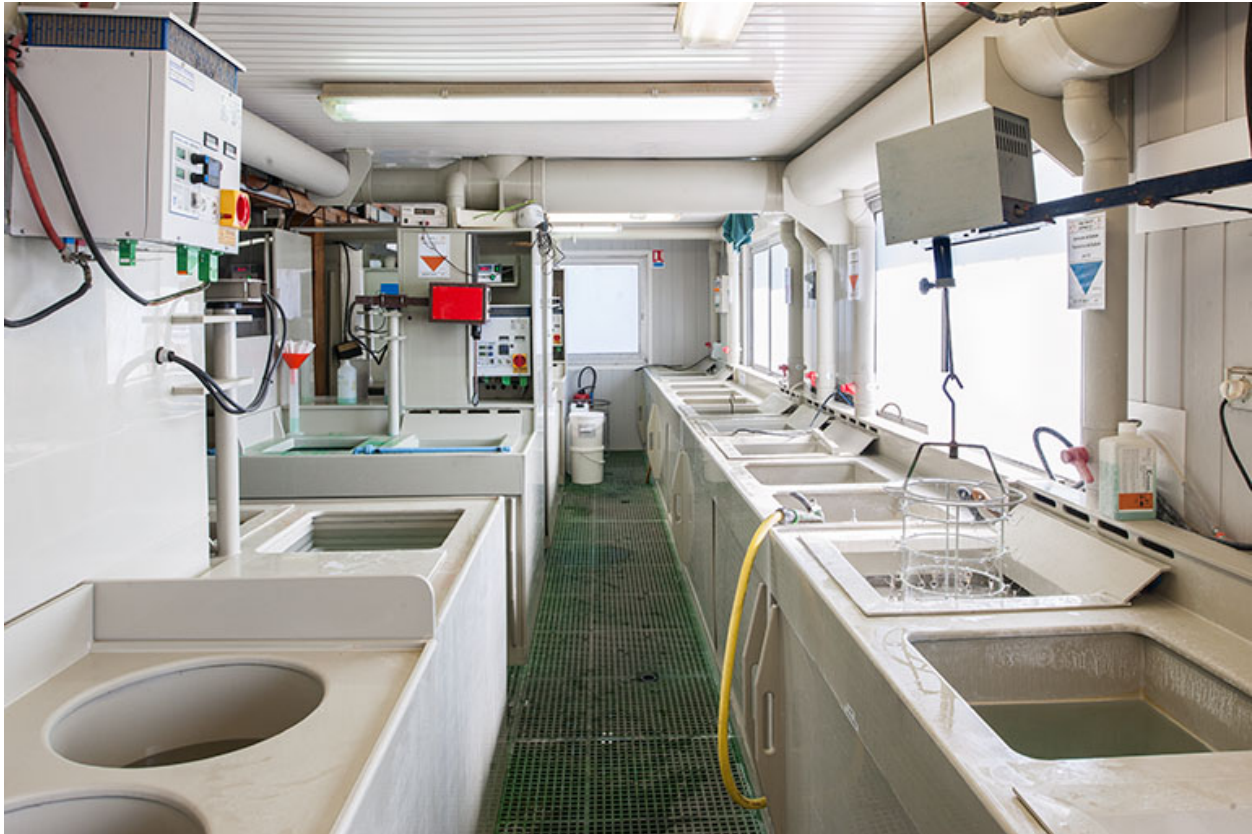
Usine : atelier de galvanoplastie (installations à l'arrière de la façade postérieure).
