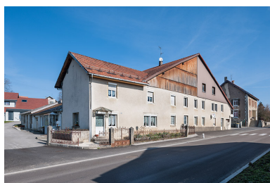
Ferme : façade antérieure, de trois quarts gauche. Phot. Jérôme Mongreville IVR43_20142500292NUC4A
