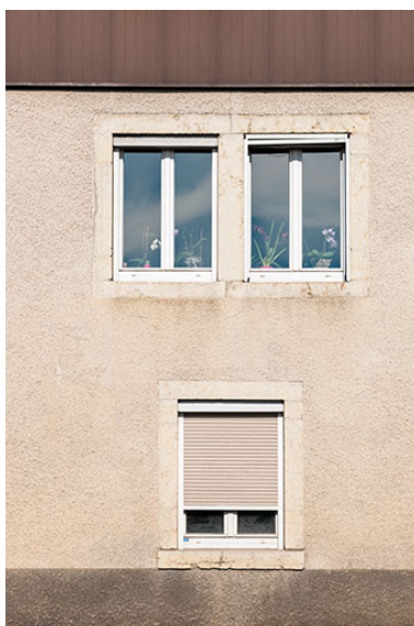
Ferme : fenêtres horlogères sur la partie droite de la façade antérieure. Phot. Jérôme Mongreville IVR43_20142500294NUC4A
