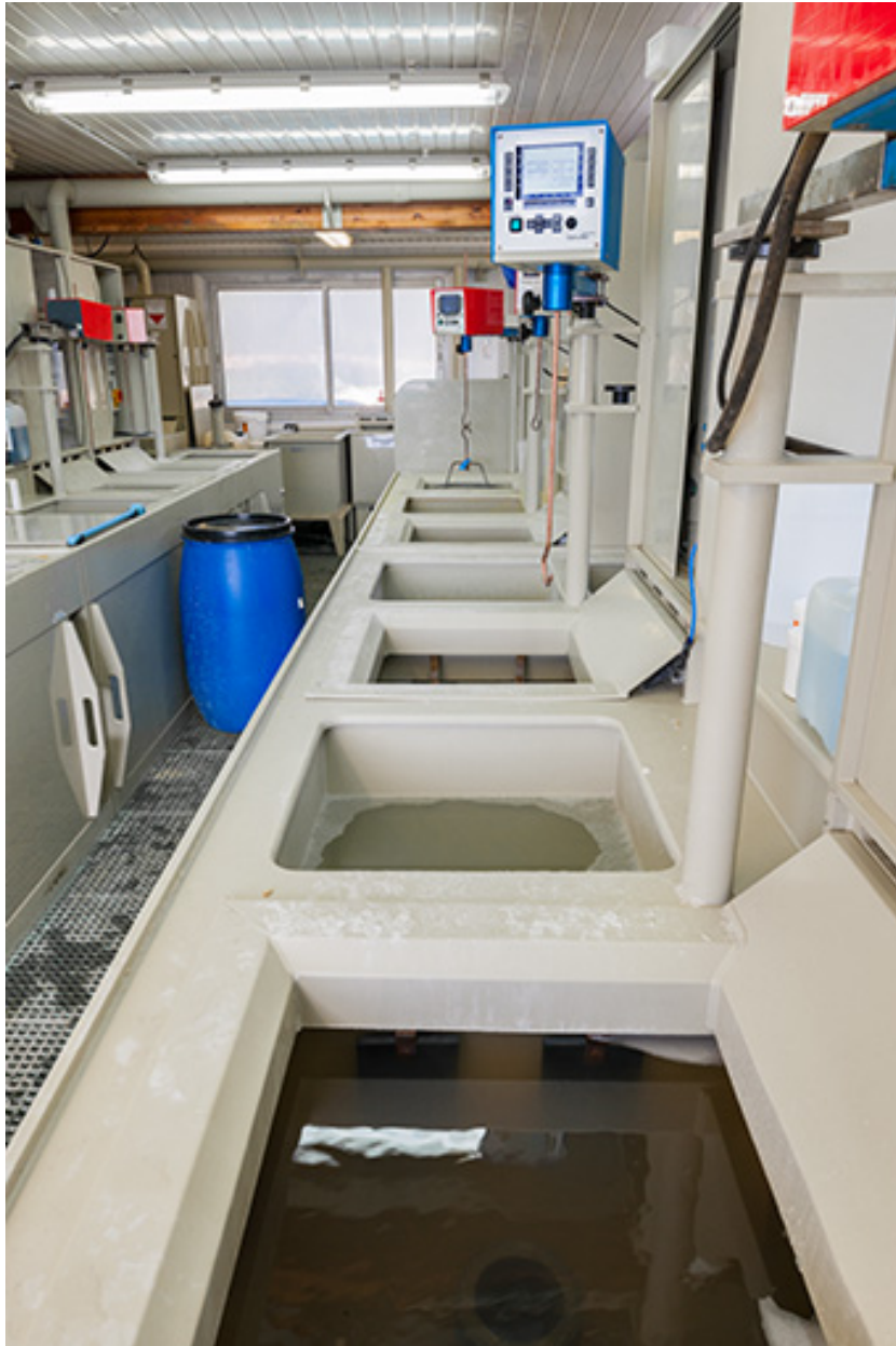
Usine : atelier de galvanoplastie (installations à l'arrière de la façade latérale gauche).
