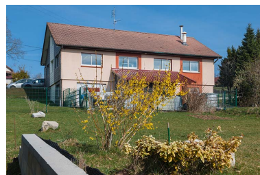
Usine : façade postérieure. Phot. Jérôme Mongreville IVR43_20142500295NUC4A
