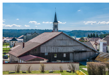
Ferme : façade postérieure. Phot. Jérôme Mongreville IVR43_20142500307NUC4A
