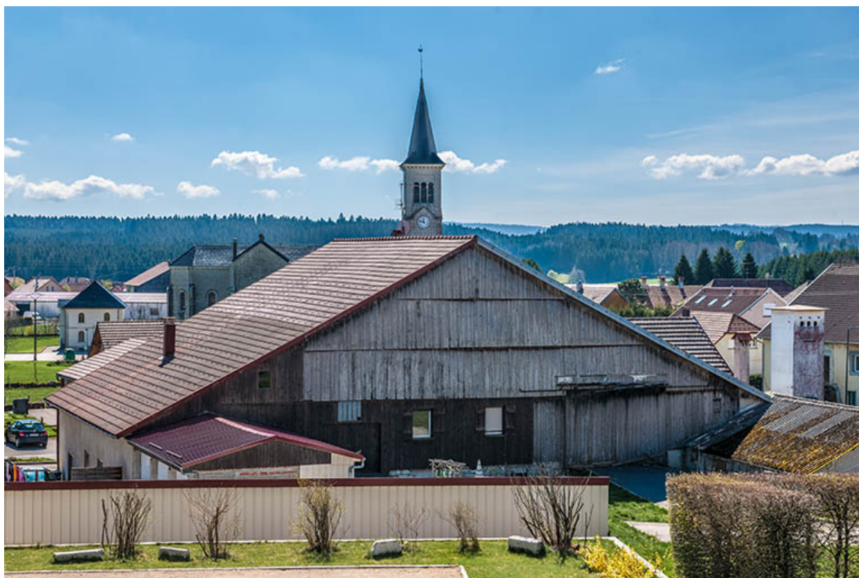
Ferme : façade postérieure.
