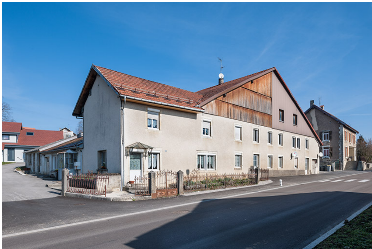
Ferme : façade antérieure, de trois quarts gauche.
