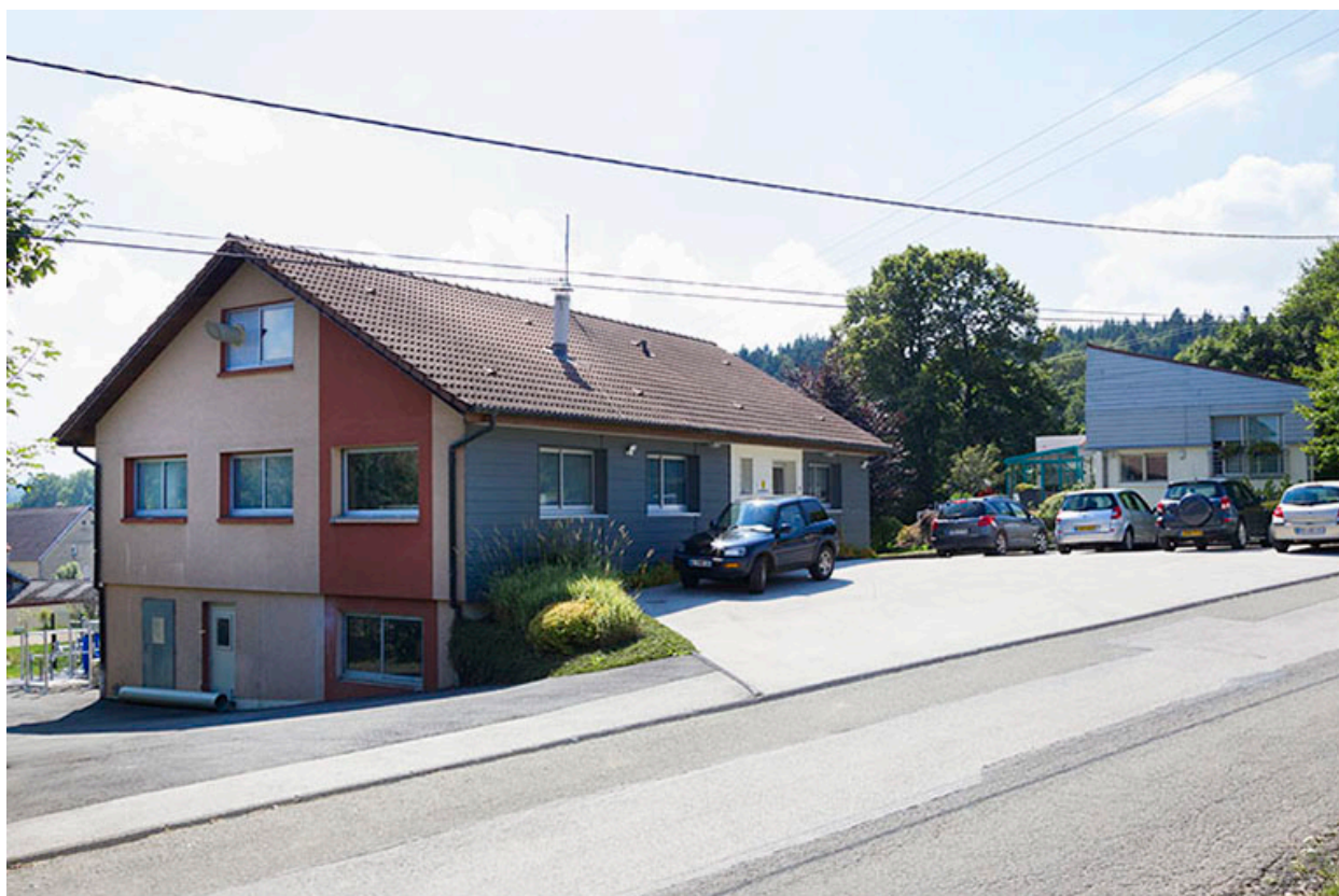
Usine : façade antérieure.
