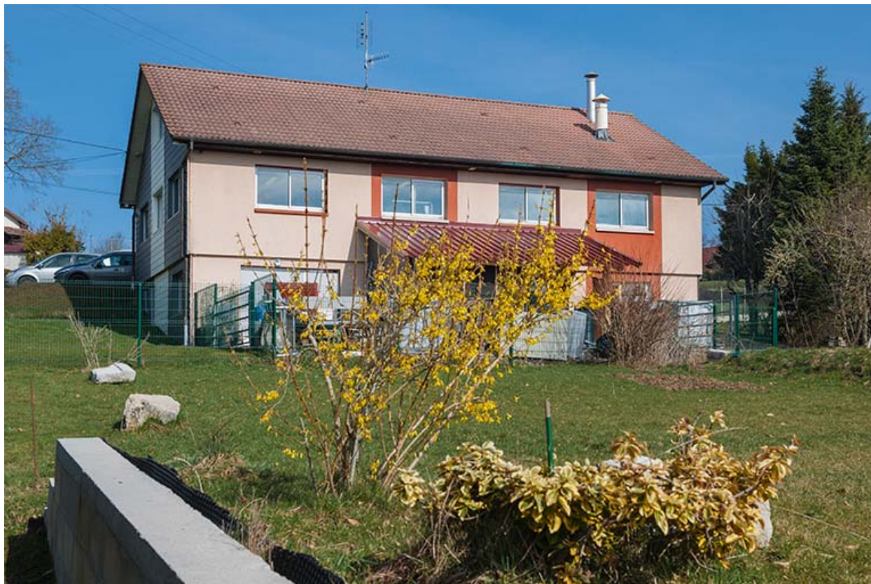
Usine : façade postérieure.
