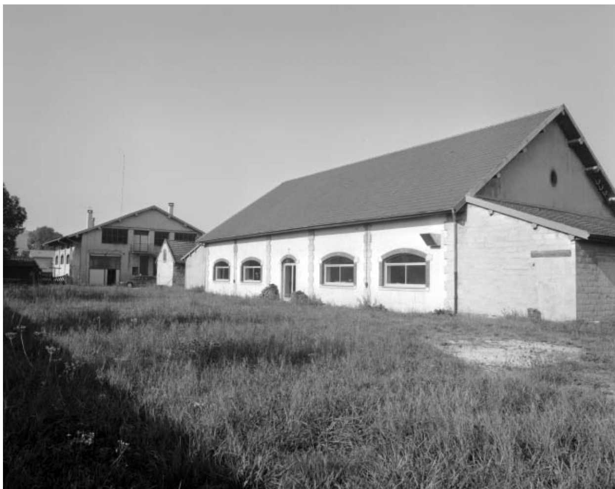
Façade postérieure de l'atelier de fabrication.
