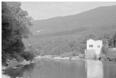
Vue d'ensemble, depuis l'aval. Phot. Laurent Poupard IVR43_19903900467Z
