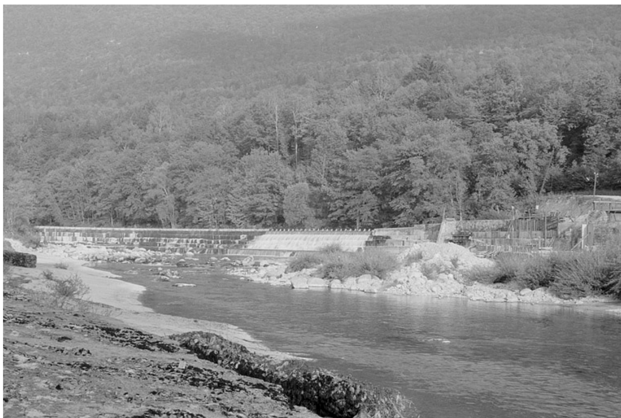
Barrage, vu de l'aval.
