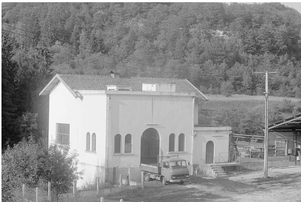
Façades antérieure et latérale gauche.
