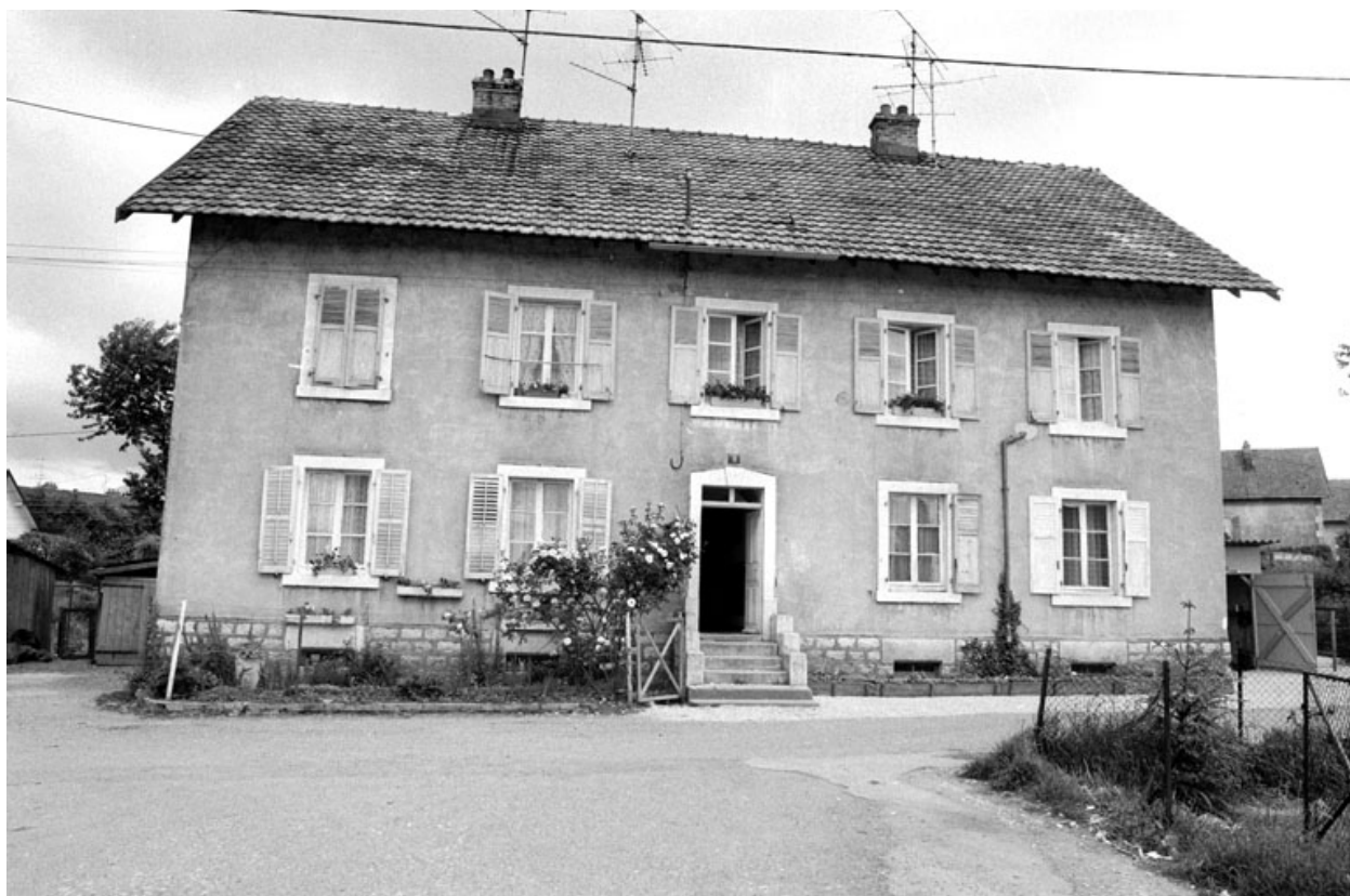
Maison ouvrière à quatre logements en 1980.
