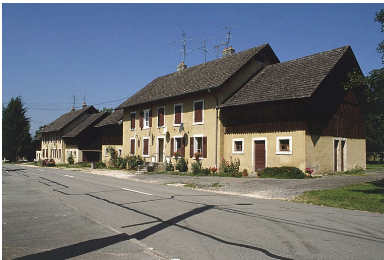
Logements collectifs route de Boron.
