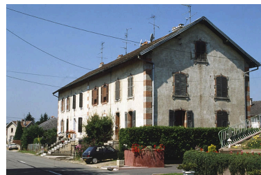
Maison à logements multiples route de Boron. Phot. Yves Sancey IVR43_20019000285ZA
