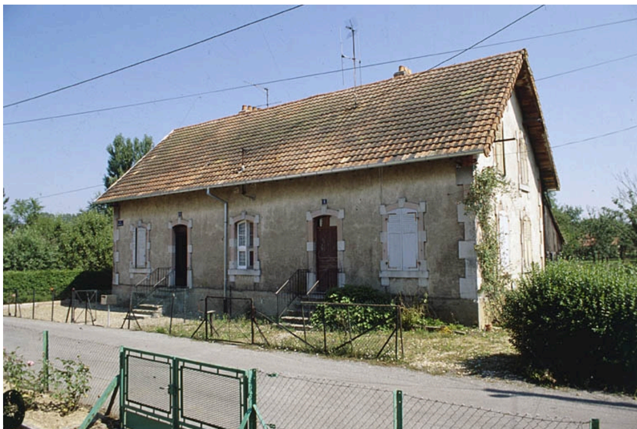
Maison à deux logements rue Rossat.
