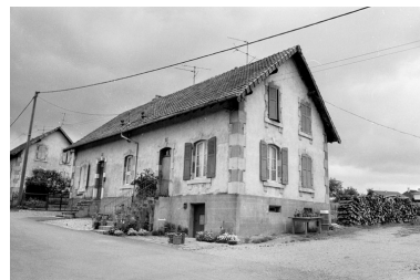
Maison ouvrière à deux logements en 1980. Phot. Bernard Lardière IVR43_19809000071Z
