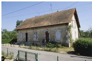
Maison à deux logements rue Rossat. Phot. Yves Sancey IVR43_20019000283ZA
