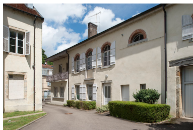
Les communs, vue depuis la cour. Phot. Jérôme Mongreville IVR43_20177001032NUC4A
