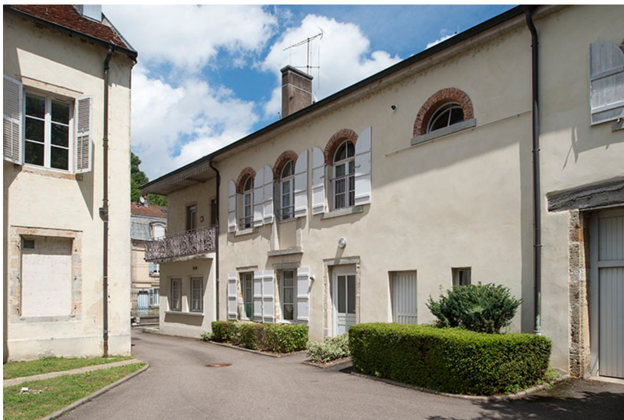
Les communs, vue depuis la cour.
