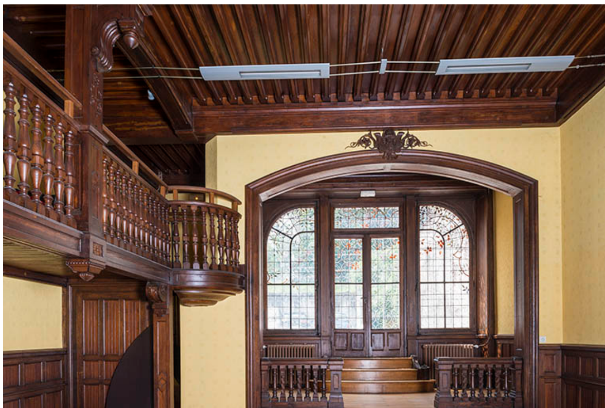
Vue sur l'estrade et la mezzanine.
