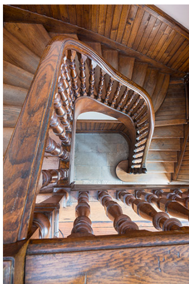
L'escalier à deux quarts tournant. Phot. Jérôme Mongreville IVR43_20177000876NUC4A
