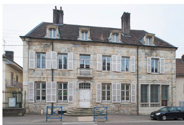
Vue générale. Phot. Jérôme Mongreville IVR43_20177000464NUC4A
