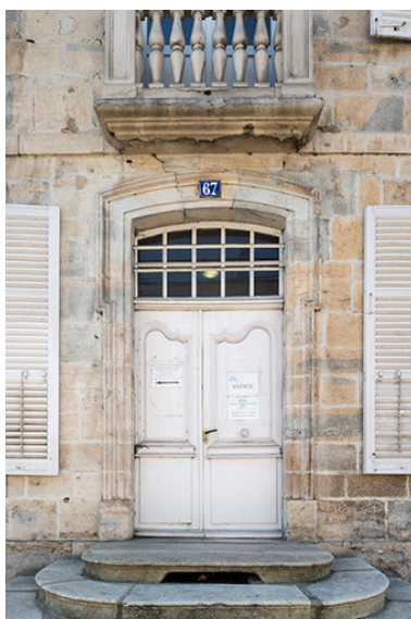
La porte d'entrée. Phot. Jérôme Mongreville IVR43_20177001036NUC4A
