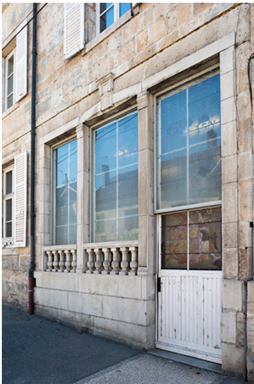
Partie occidentale de la façade antérieure.
