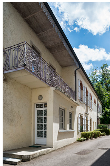
Vue latérale des communs. Phot. Jérôme Mongreville IVR43_20177001029NUC4A
