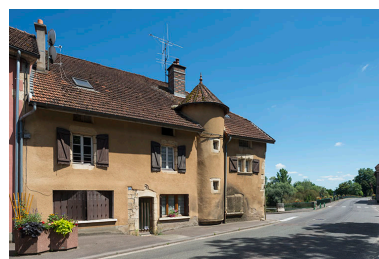
Élévation sur la rue Armand Paulmard, vue de trois-quarts. Phot. Jérôme Mongreville IVR43_20187000445NUC4A
