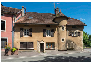
Élévation sur la rue Armand Paulmard. Phot. Jérôme Mongreville IVR43_20187000446NUC4A
