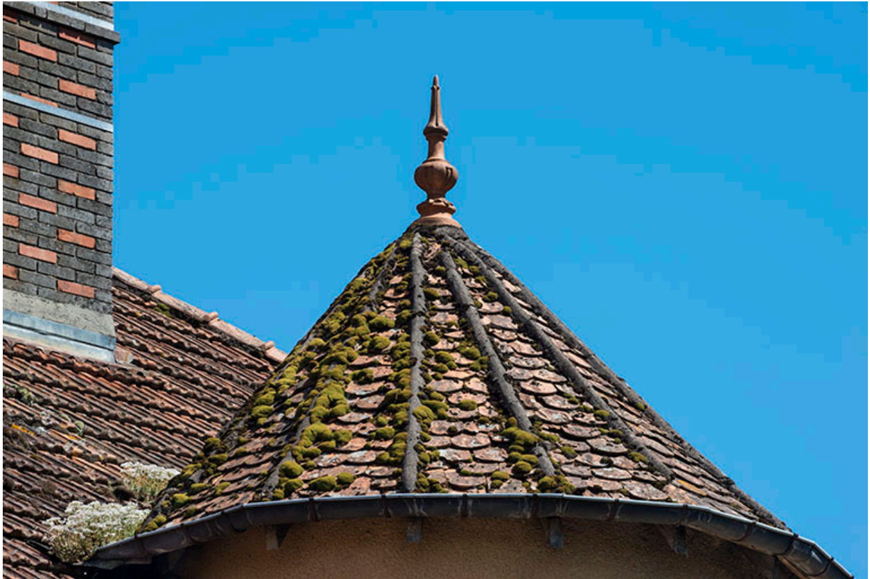
Toit conique nervuré de la tour demi-hors-œuvre.
