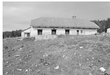
Façade antérieure. Phot. Jérôme Mongreville IVR43_19963901517X
