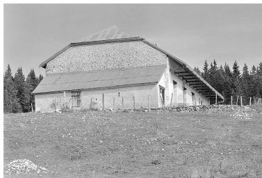
Face sud-ouest. Phot. Jérôme Mongreville IVR43_19963901514X
