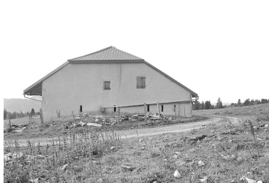
Face nord-est. Phot. Jérôme Mongreville IVR43_19963901516X
