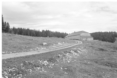
Vue générale depuis le chemin d'accès. Phot. Jérôme Mongreville IVR43_19963901512X
