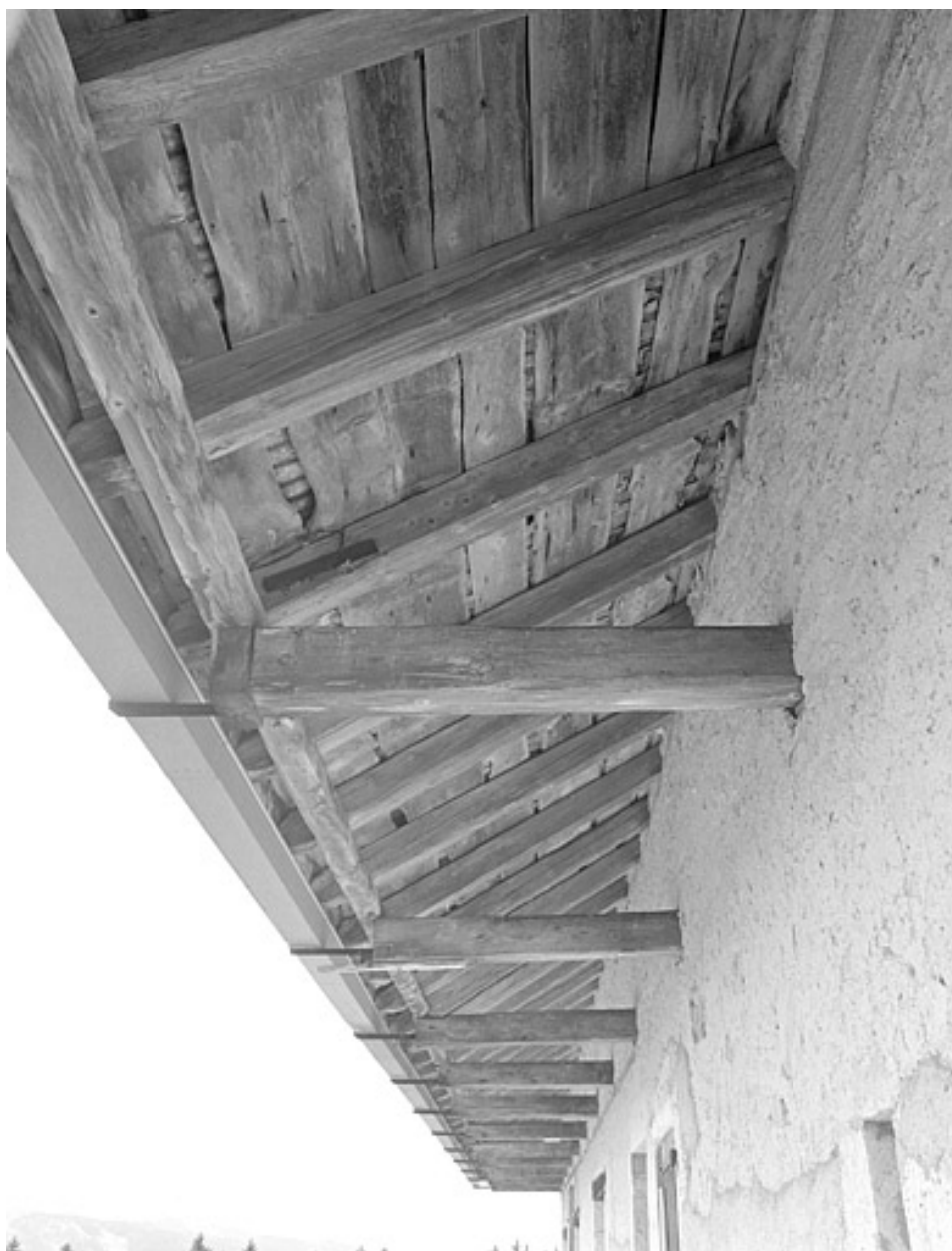
Détail de la charpente de l'avant toit.
