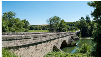
Pont sur l'Armançon. Phot. Pierre-Marie Barbe-Richaud IVR26_20122102015NUC4AQ
