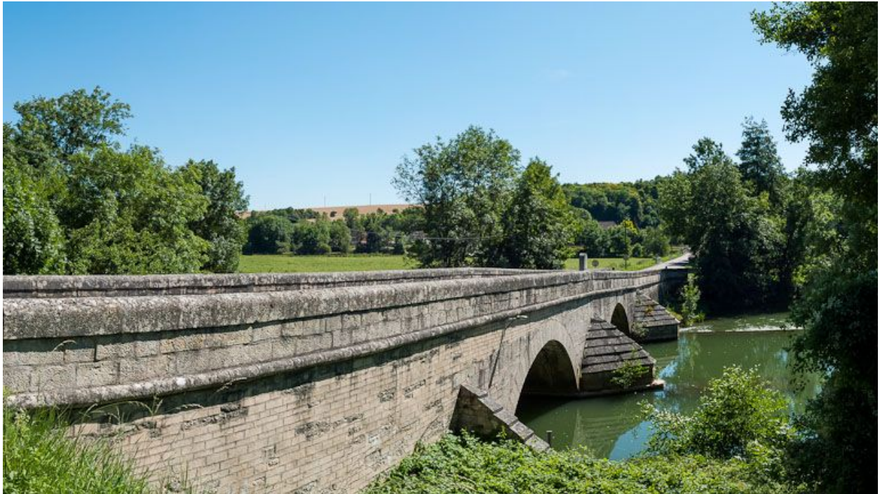
Pont sur l'Armançon.
