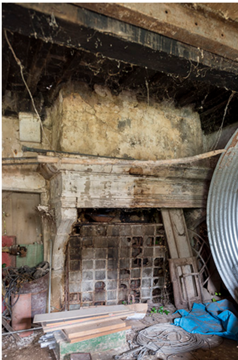
Cheminée adossée, au rez-de-chaussée de l'ancien logis.
