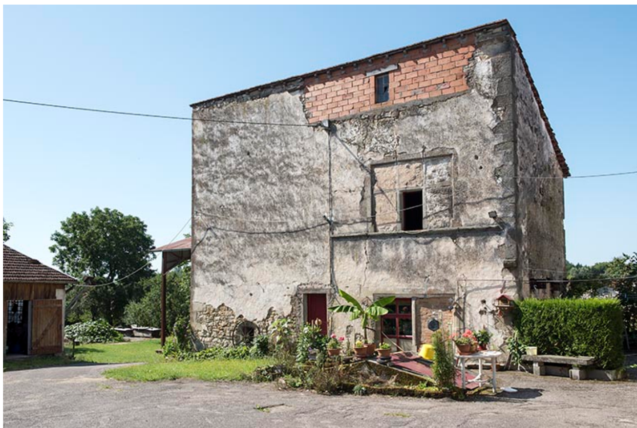
Ancien logis vu du nord-est.
