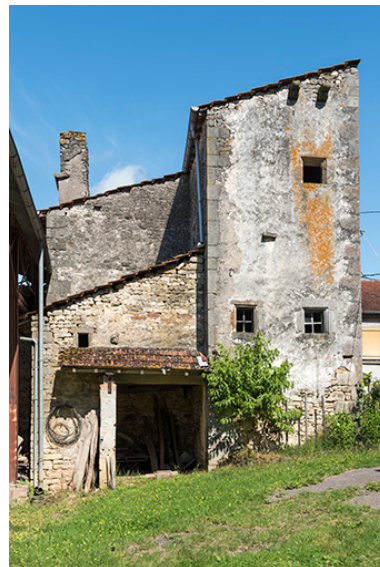
Ancien logis vu du sud-est. Phot. Sonia Dourlot IVR43_20167001232NUC4A
