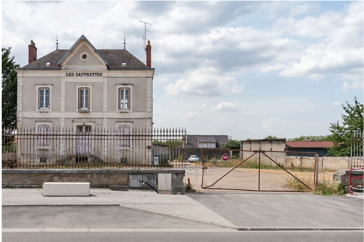
Vue d'ensemble depuis la rue du Quatre Septembre avec l'emplacement du portail (déposé).
