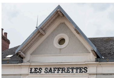
Lucarne-pignon et inscription en façade. Phot. Pierre-Marie Barbe-Richaud IVR26_20205800556NUC4A
