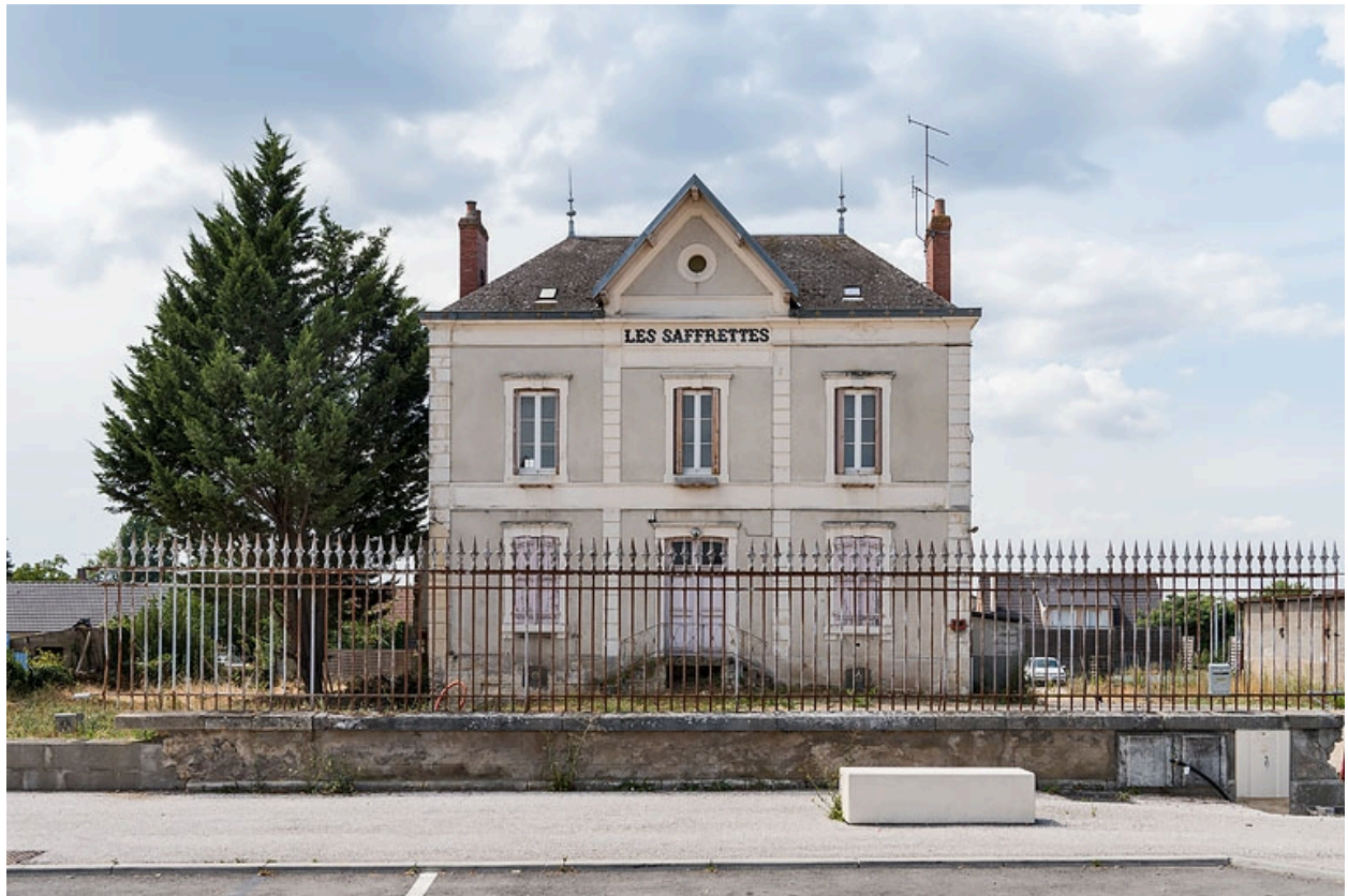
Façade de la maison.
