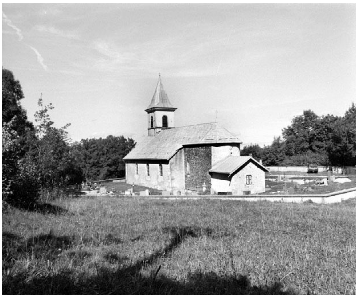
Extérieur : vue générale depuis le sud-ouest.
