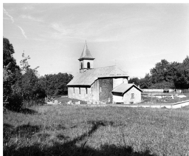
Extérieur : vue générale depuis le sud-ouest. Phot. Yves Sancey IVR43_19943900930X
