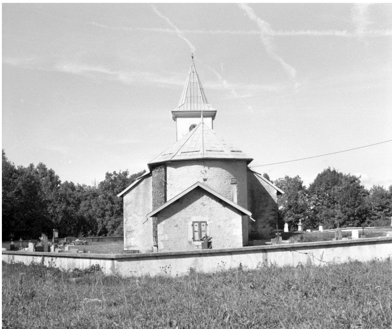
Extérieur : l'abside vue de face.
