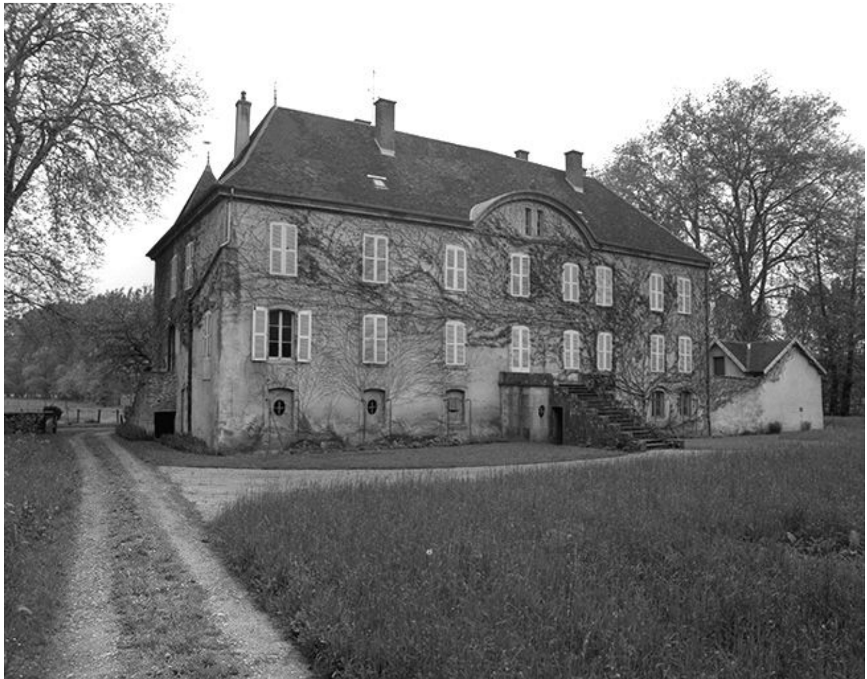
Façade principale, vue de trois quarts.
