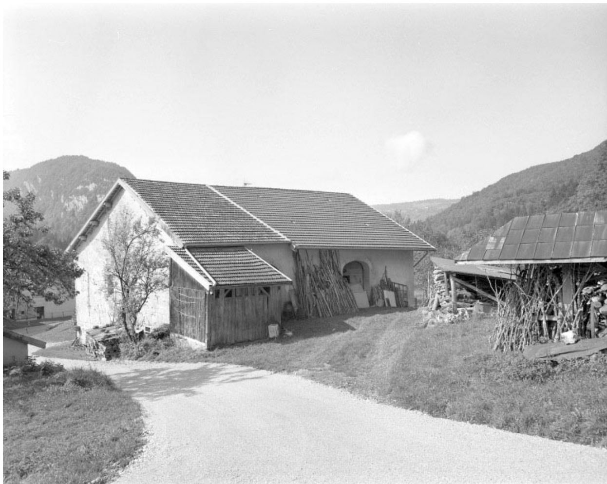
Vue générale de la façade postérieure.
