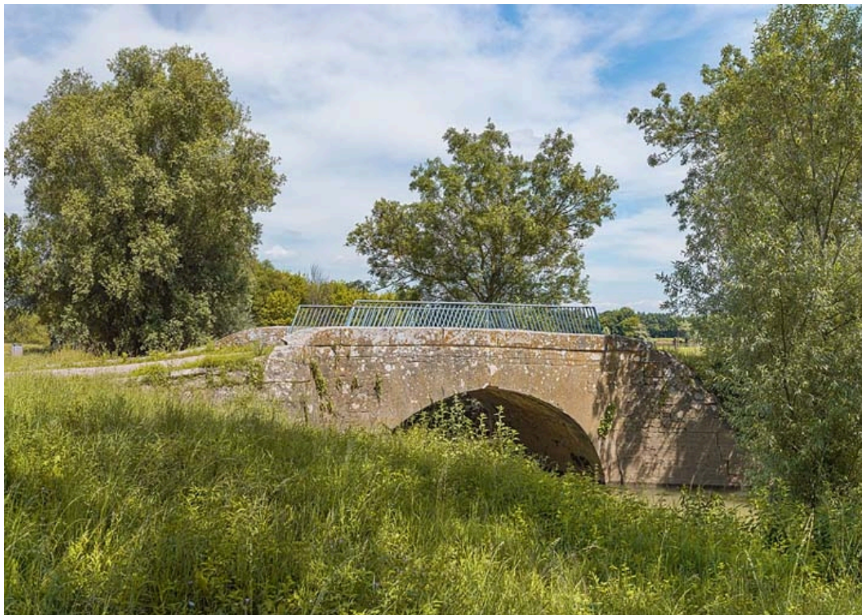
Vue d'ensemble du pont.
