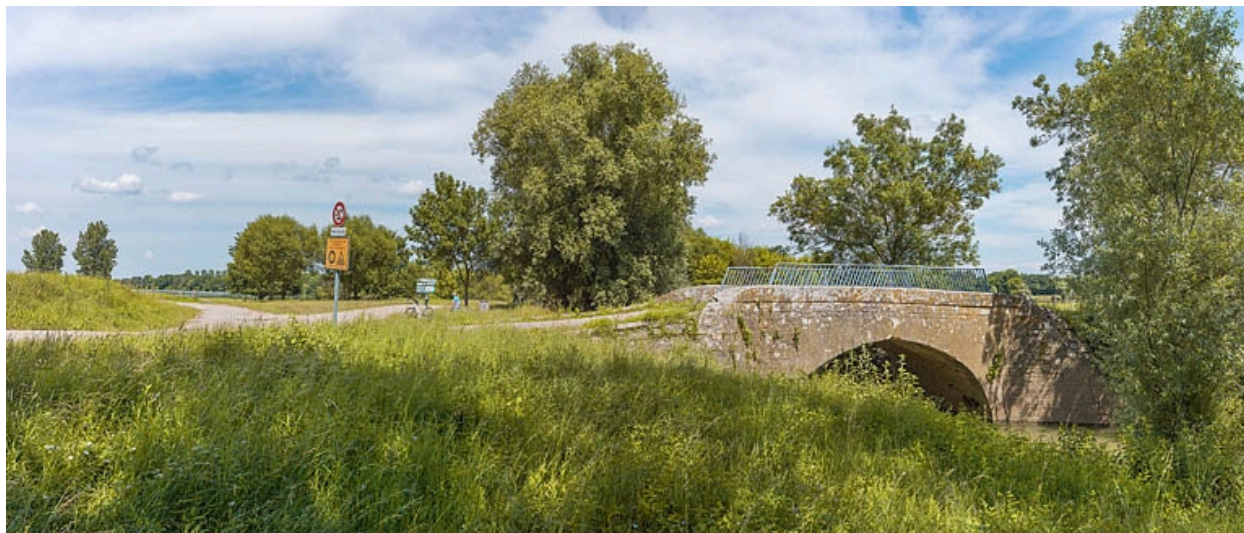
Le pont sur la Mouge, rive droite et la véloroute.
