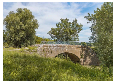
Vue d'ensemble du pont. Phot. Thierry Kuntz IVR26_20217100534NUC4A
