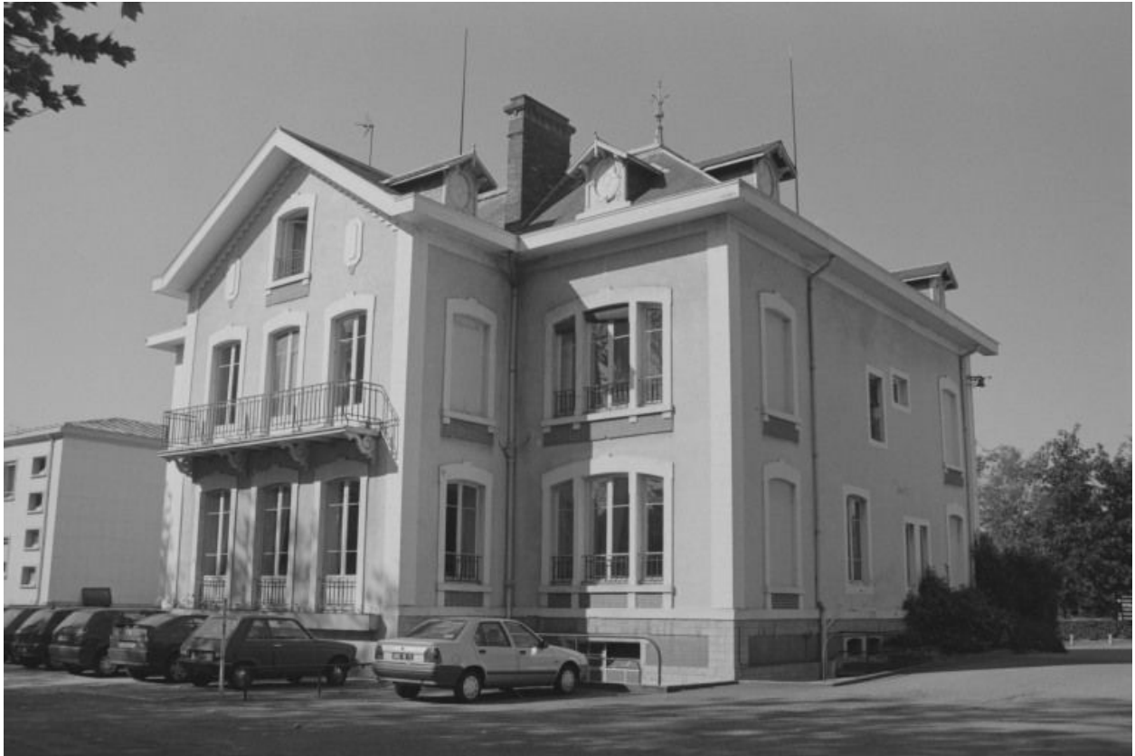
Façade antérieure du Château de Galuzot (1859-1863).
