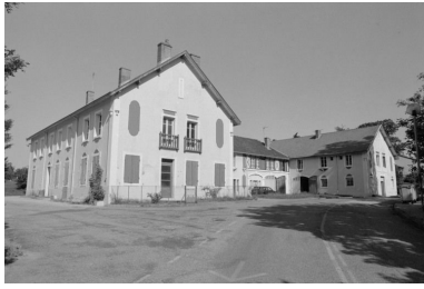
Logement des domestiques et écurie du Château de Galuzot (bâtiment d'administration et écuries de 1837-40 transformés en 1859-63). Phot. Frédéric Pillet IVR26_19987100218Z
