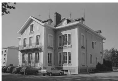
Façade antérieure du Château de Galuzot (1859-1863). Phot. Frédéric Pillet IVR26_19987100216Z
