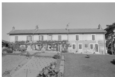
Ferme du Château de Galuzot (anciens logements ouvriers des années 1830 transformés vers 1860 - façade Sud). Phot. Frédéric Pillet IVR26_19987100219Z
