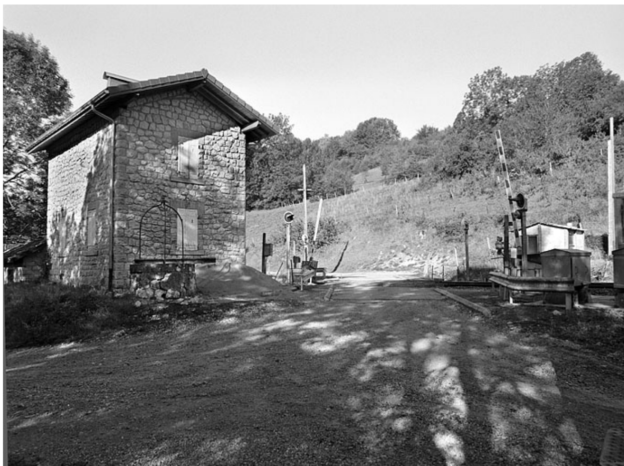
Façades postérieure et latérale gauche, puits et passage à niveau.
