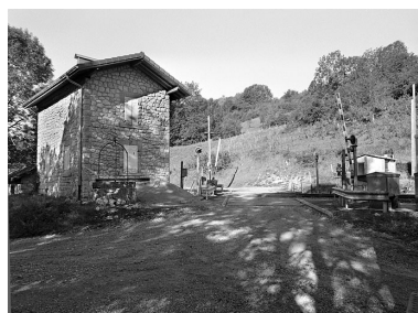
Façades postérieure et latérale gauche, puits et passage à niveau. Phot. Yves Sancey IVR43_20043900346X
