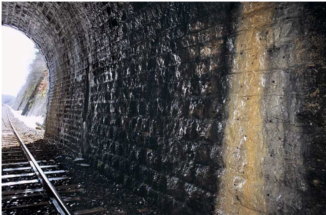
Intérieur (côté La Cluse) : appareil à bossages du mur et voile de calcite.
