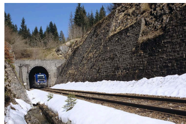
Vue d'ensemble de la tête côté La Cluse, avec autorail X 73500. Phot. Yves Sancey IVR43_20053900237ZA
