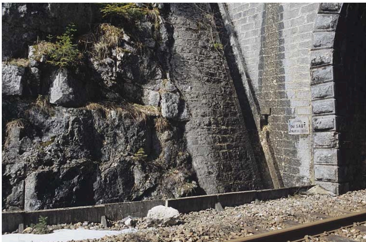
Tête côté La Cluse : descente d'eau, chantepleure et caniveau (détail).
