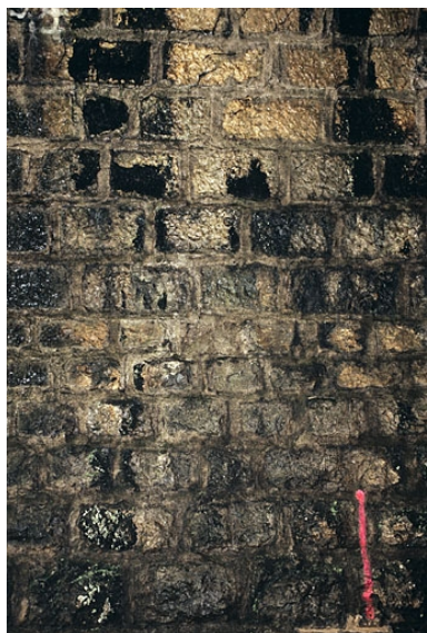
Intérieur : détail du changement d'appareil entre piédroit et voûte. Phot. Yves Sancey IVR43_20053900251ZA
