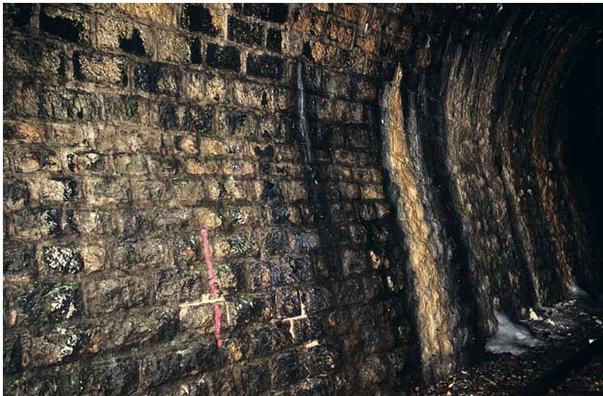
Intérieur (côté La Cluse) : appareil à bossages du mur et voile de calcite.
