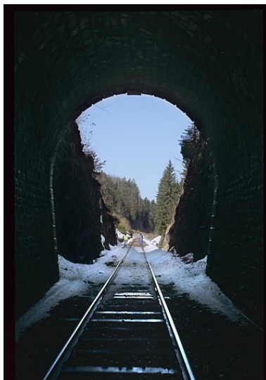
Intérieur (côté Andelot-en-Montagne) : tête. Phot. Yves Sancey IVR43_20053900242ZA
