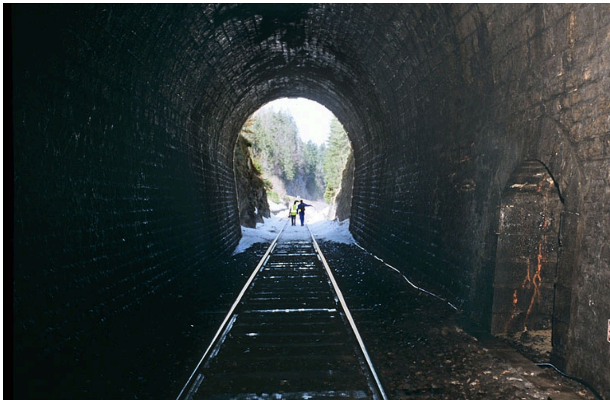
Intérieur (côté Andelot-en-Montagne) : tête et refuge.
