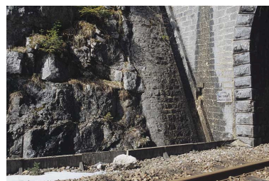
Tête côté La Cluse : descente d'eau, chantepleur et caniveau (détail). Phot. Yves Sancey IVR43_20053900240ZA
