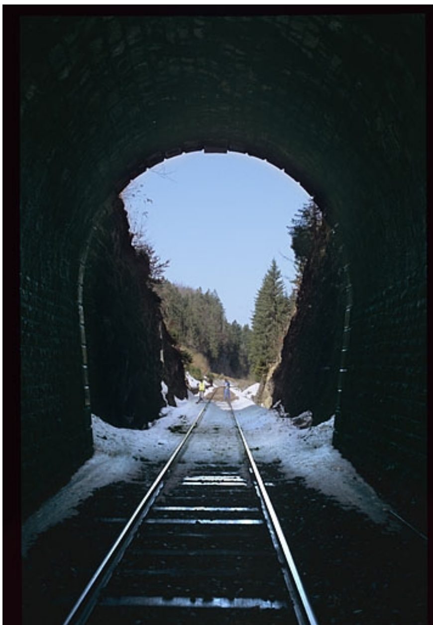
Intérieur (côté Andelot-en-Montagne) : tête.
