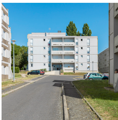
Bâtiment 27, façade antérieure ouest.
