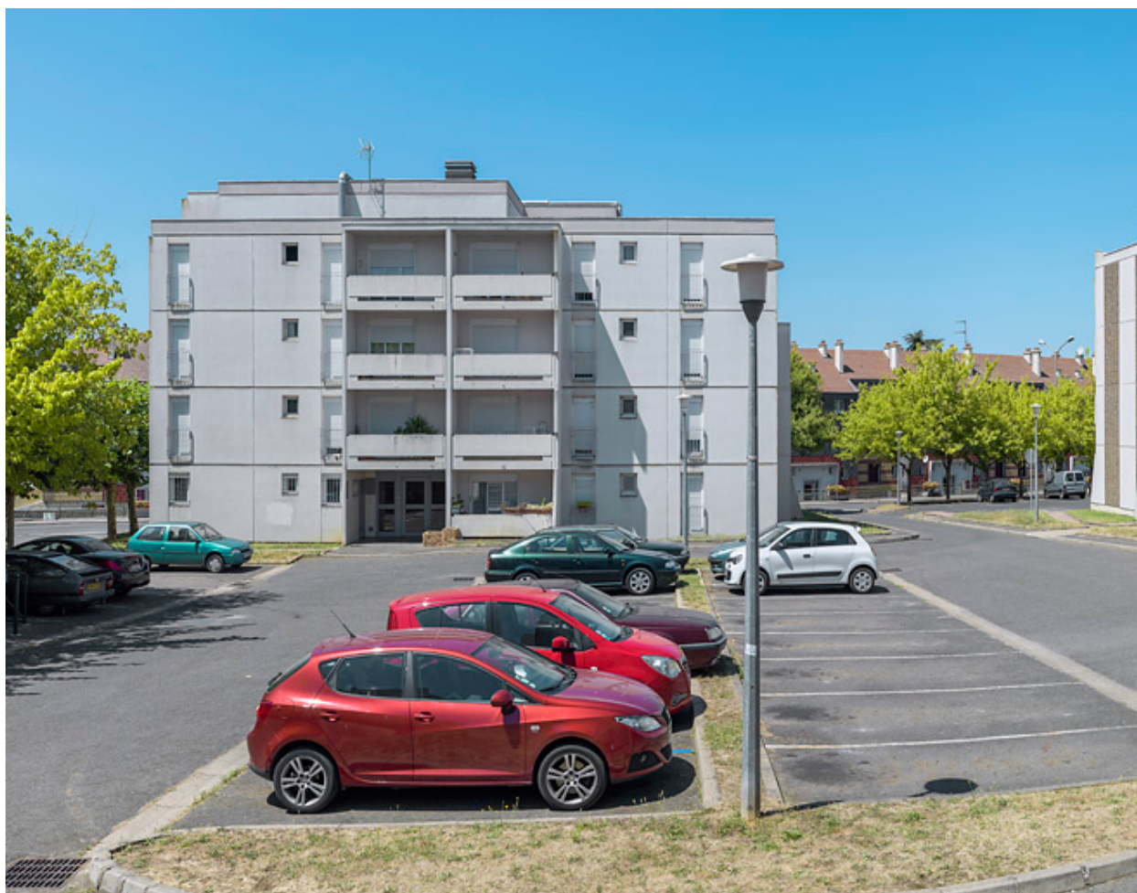
Bâtiment 25, façade antérieure est.
