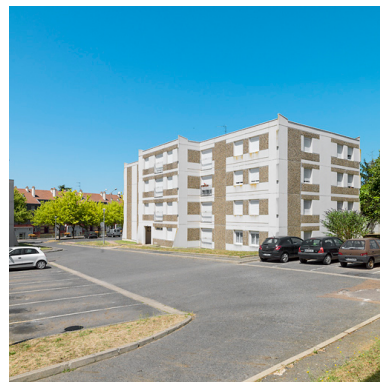
Bâtiment 26, façades antérieure et latérale.
