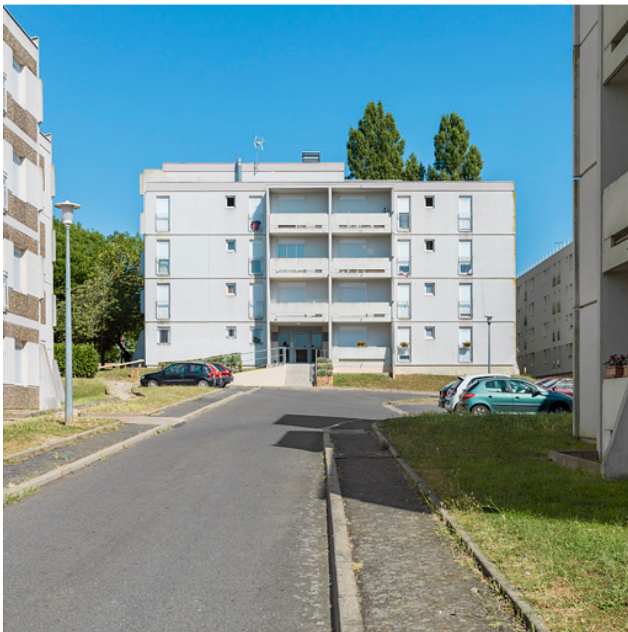
Bâtiment 27, façade antérieure ouest.
