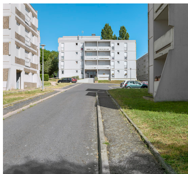
Bâtiment 27, façade antérieure ouest.
