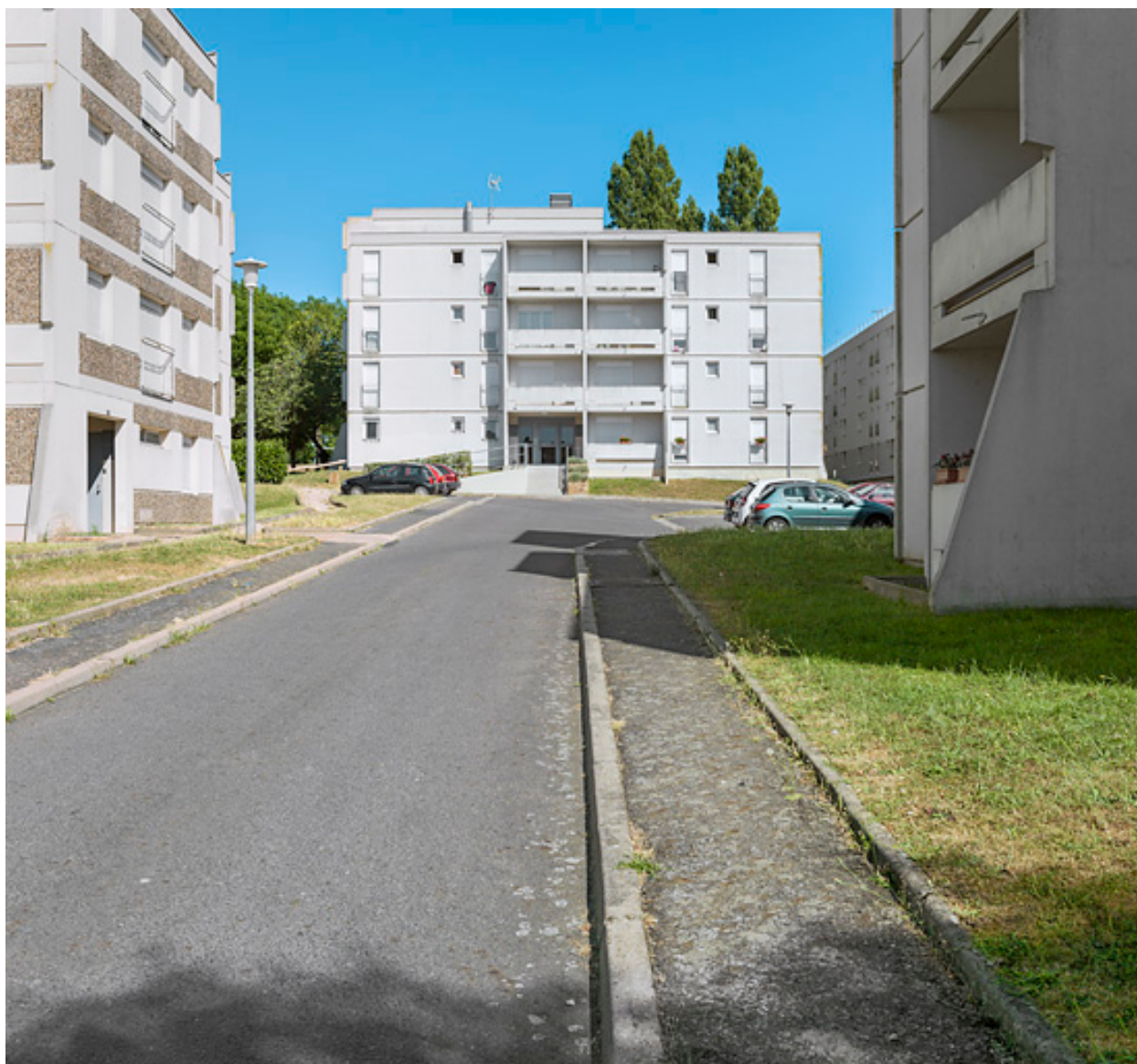
Bâtiment 27, façade antérieure ouest.
