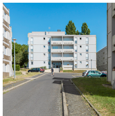
Bâtiment 27, façade antérieure ouest.
