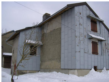
Vue du pignon sud-ouest. Phot. Marie-Pierre Reynet IVR43_20083900219NUC1A
