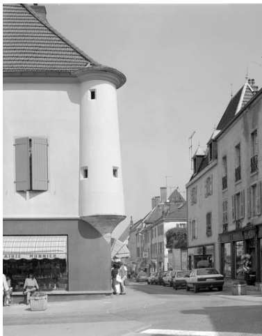
Détail de l'oriel. Phot. Yves Sancey IVR43_19897000353V
