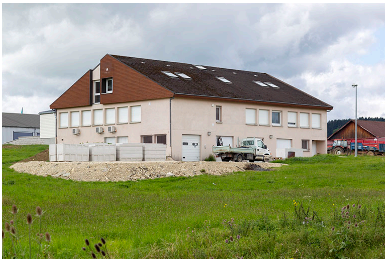
Façades postérieure et latérale droite.
