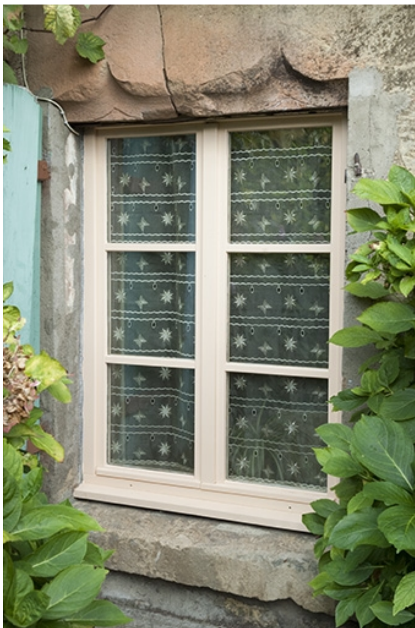
Détail de la baie de l'ancienne cuisine (actuelle salle à manger).
