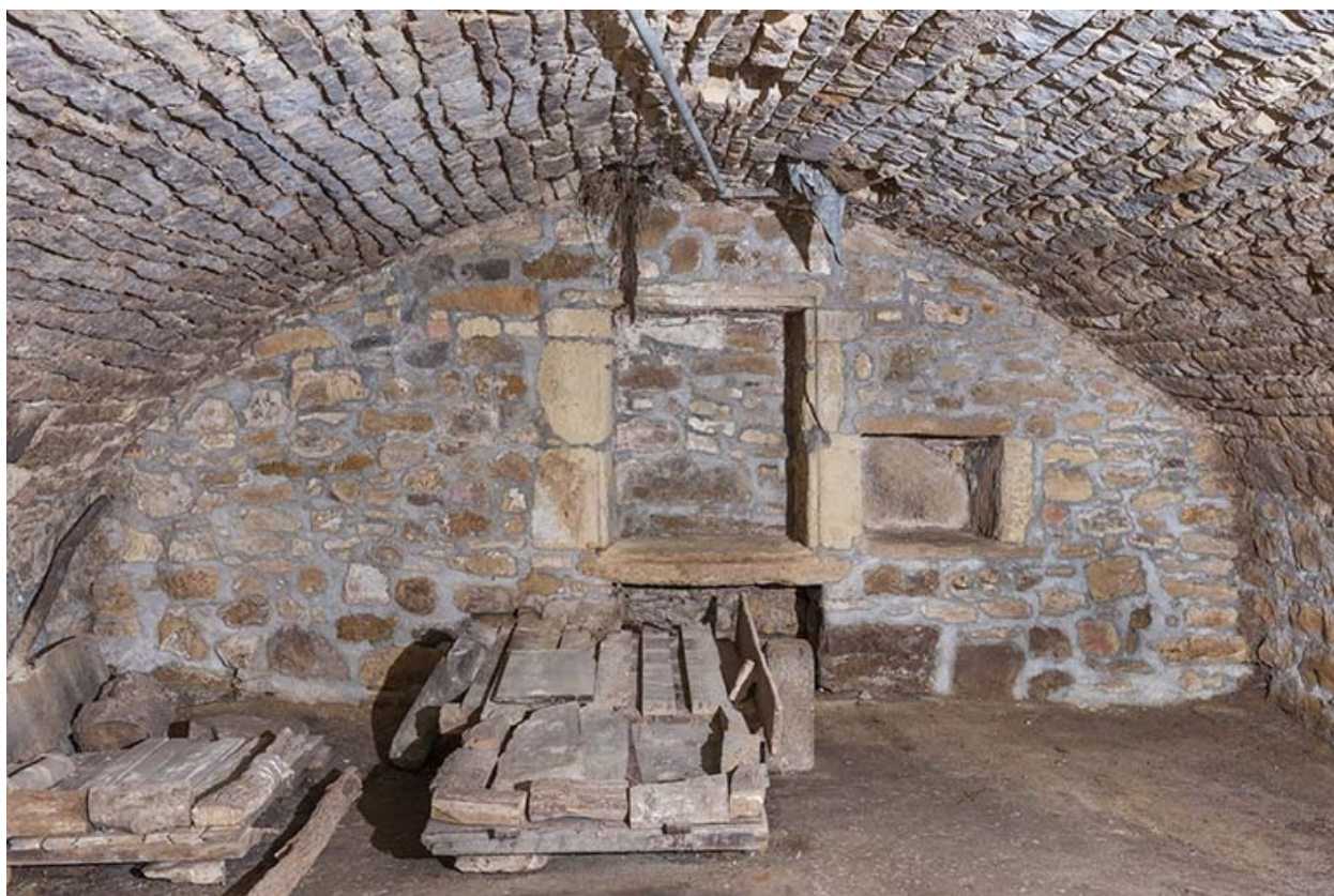
Sous-sol, depuis l'entrée.
