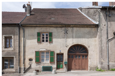
Façade antérieure. Phot. Jérôme Mongreville IVR43_20127000107NUC4A
