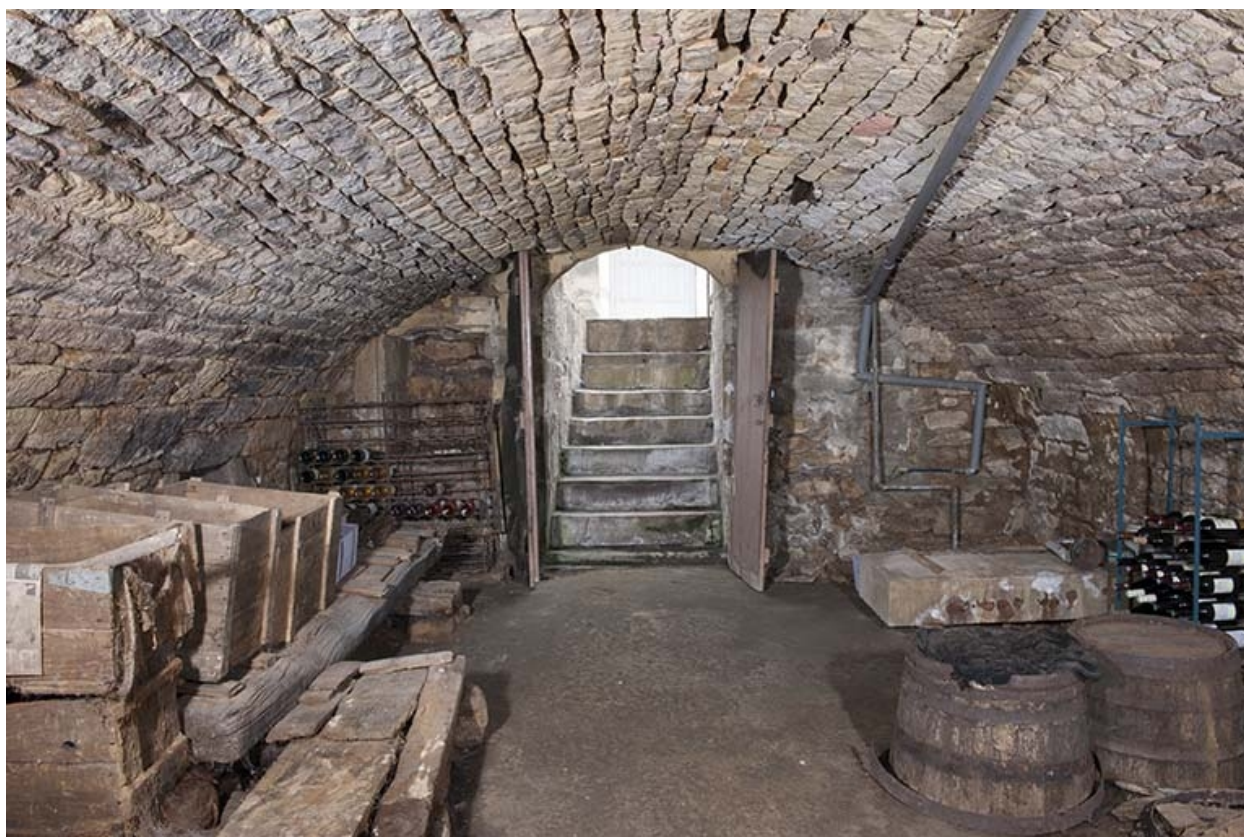
Sous-sol, en direction de l'entrée.
