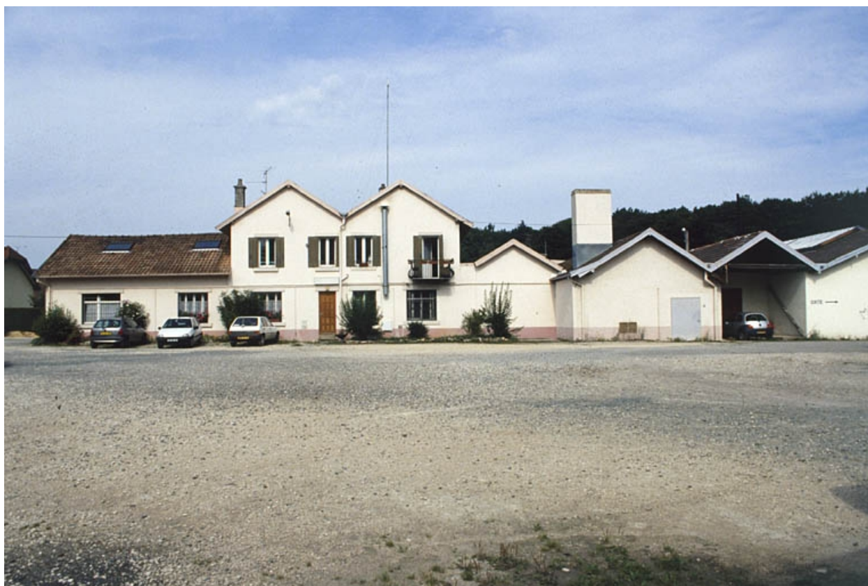
Façade postérieure des bâtiments sur rue.
