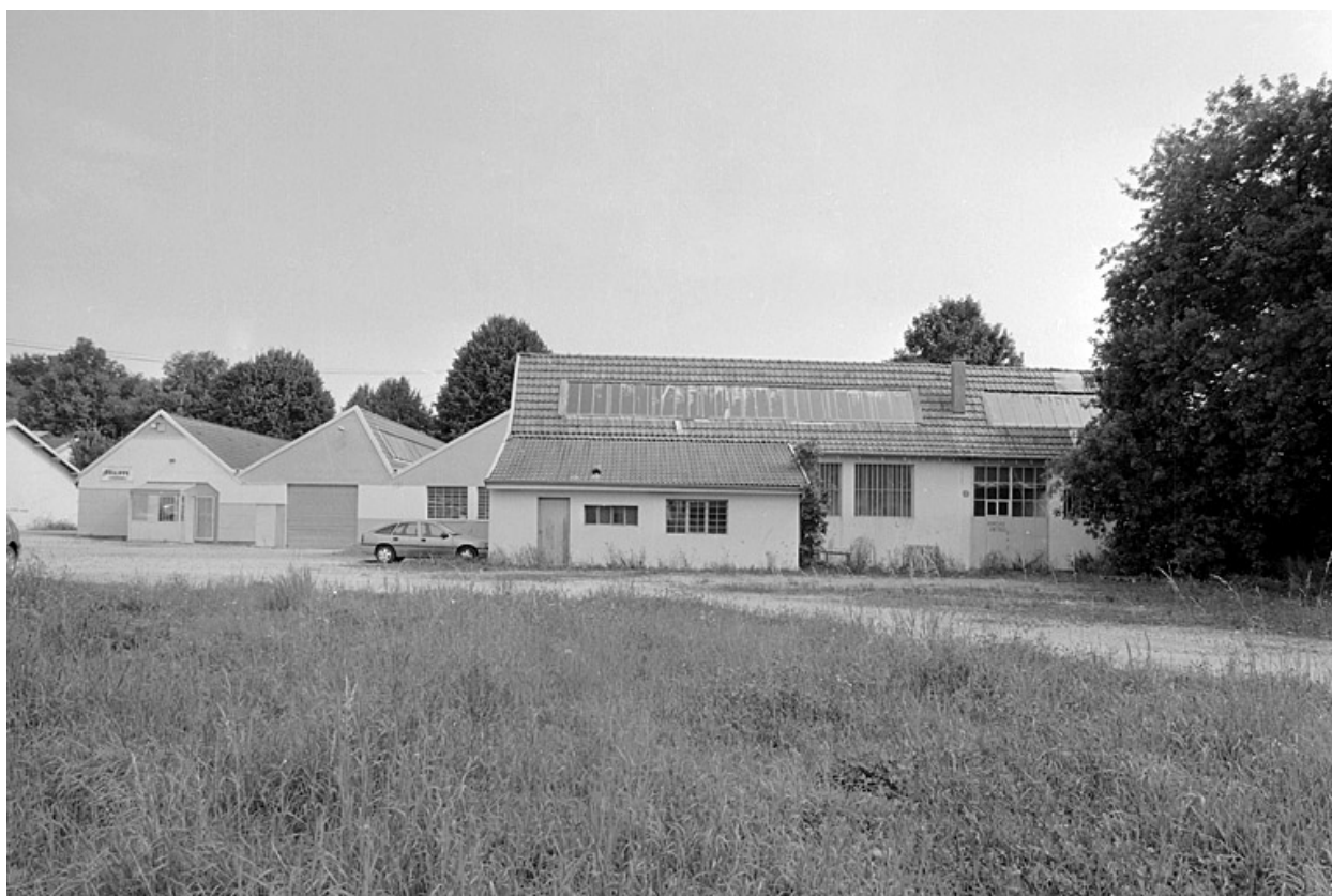
Ateliers de fabrication depuis le sud.
