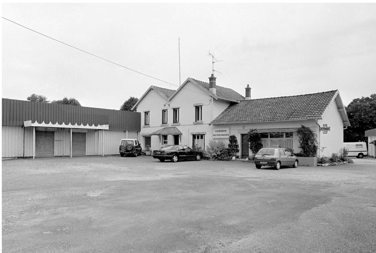
Façade des bureaux (?).
