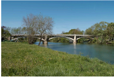
Pont routier sur la D933. Phot. Jean-Luc Duthu IVR26_20107100527NUC2A
