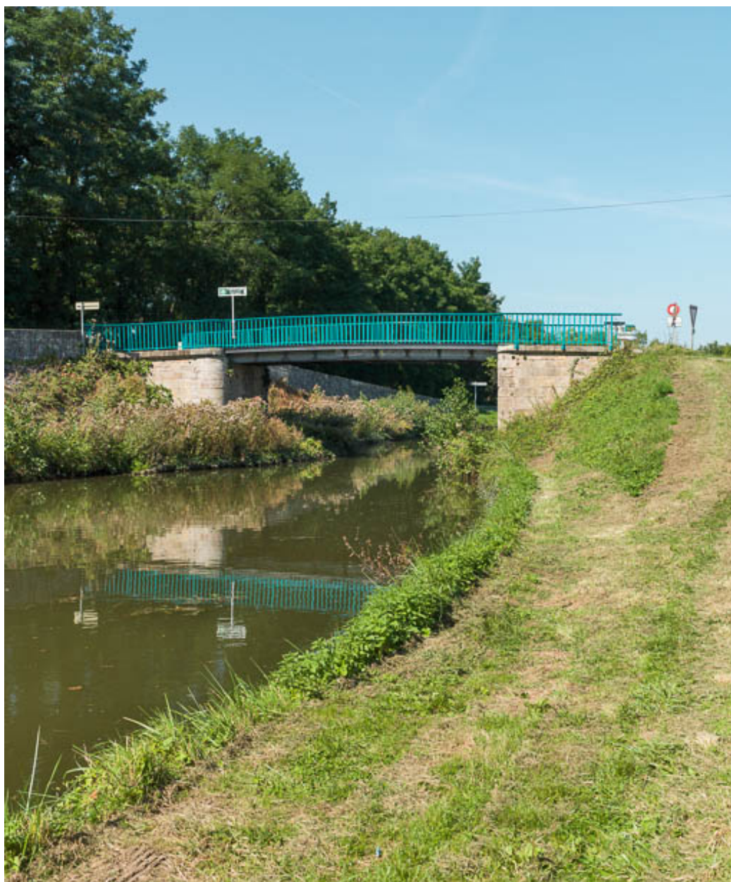
Vue d'ensemble du pont.
