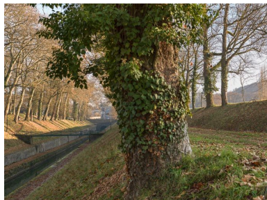
Vue de la tranchée avec la passerelle. Phot. Pierre-Marie Barbe-Richaud IVR26_20132101066NUC4AQ
