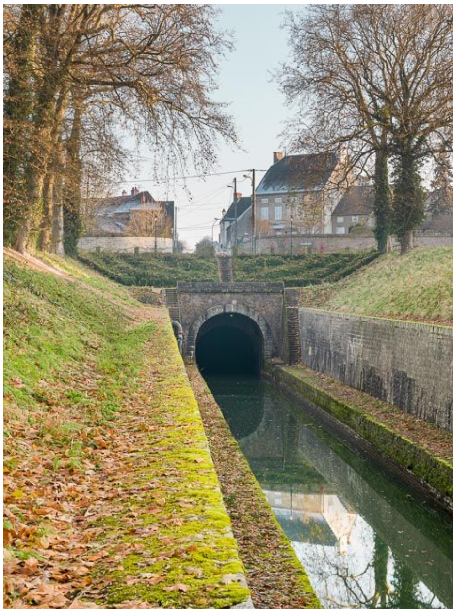
Sortie du tunnel côté Pouilly.
