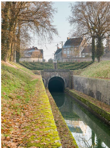
Sortie du tunnel côté Pouilly. Phot. Pierre-Marie Barbe-Richaud IVR26_20132101067NUC4A
