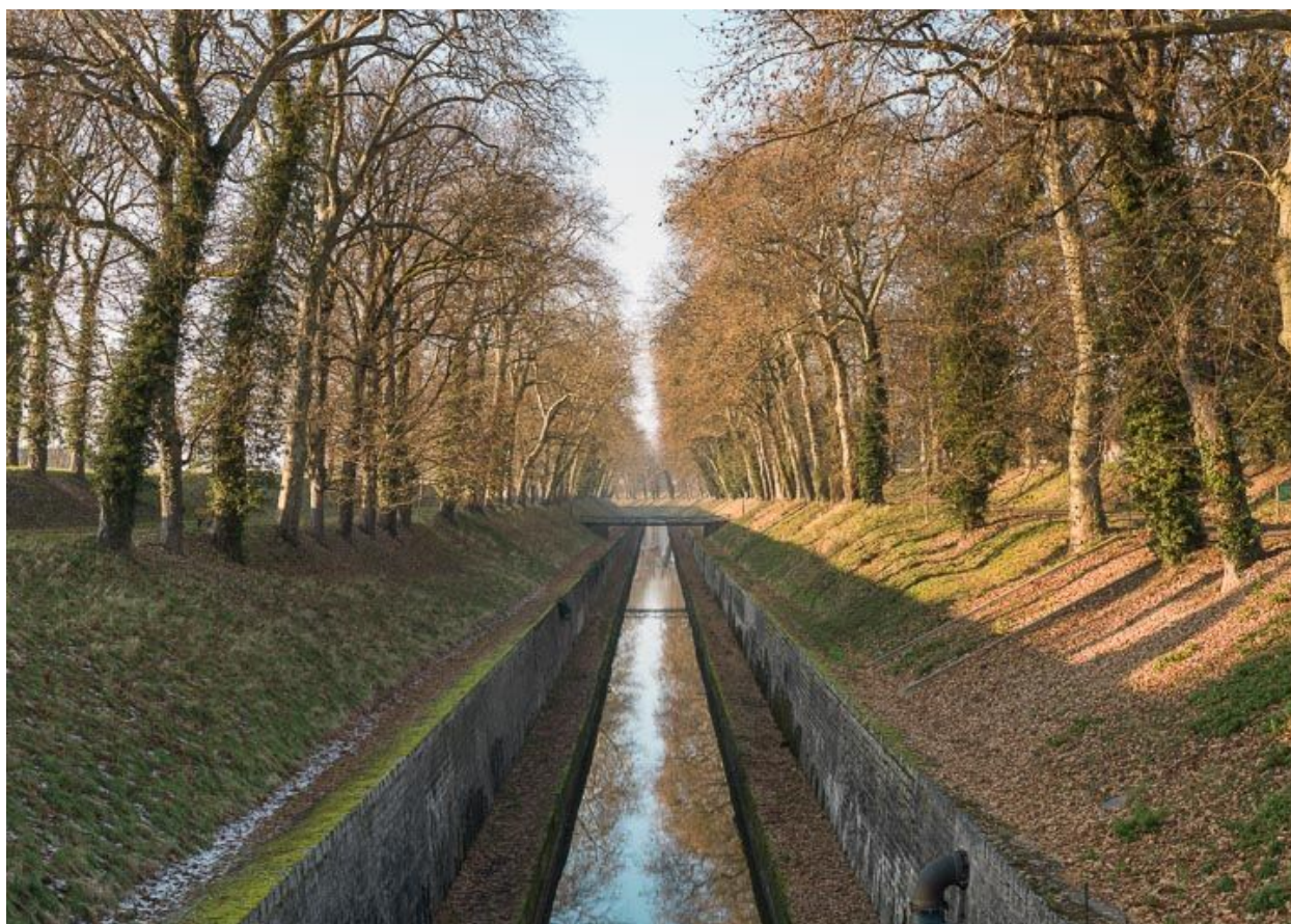
Vue d'ensemble de la tranchée.
